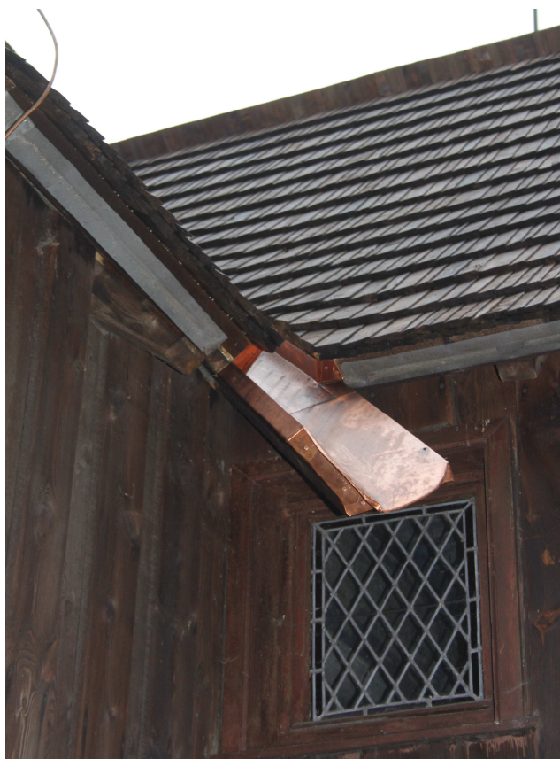
Ausschnitt neue Dachschindeldeckung Nordseite, Ende November 2014
