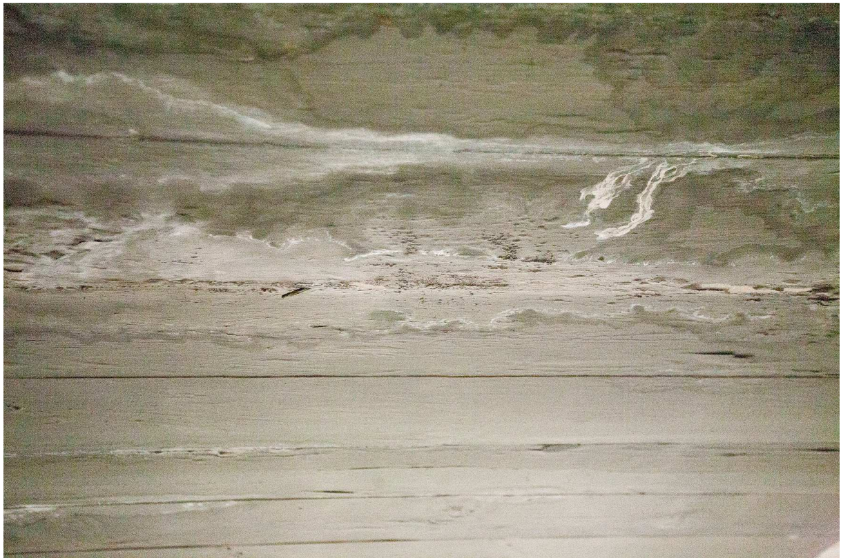
Wasserschaden an Innenverbreiterung und -bemalung, 2013 (Foto: Monument-Service)
