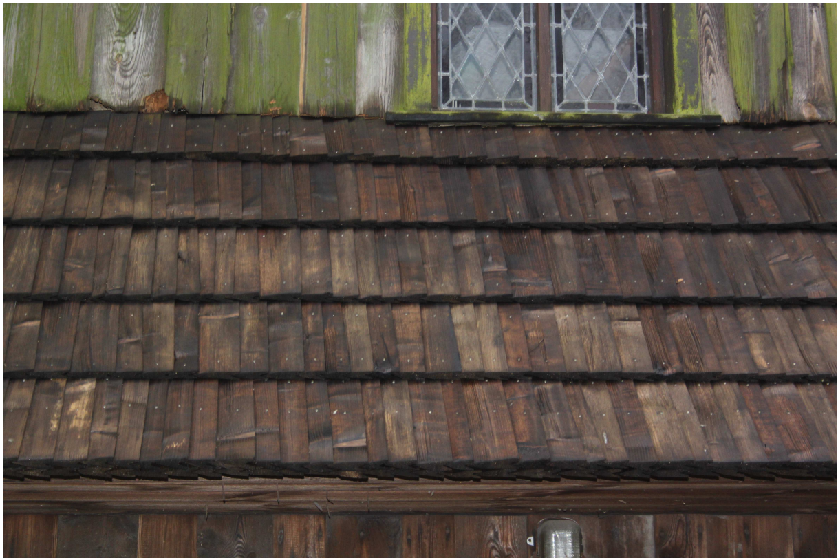
Neuegedeckte Turmdachabseite, Ende November 2014
