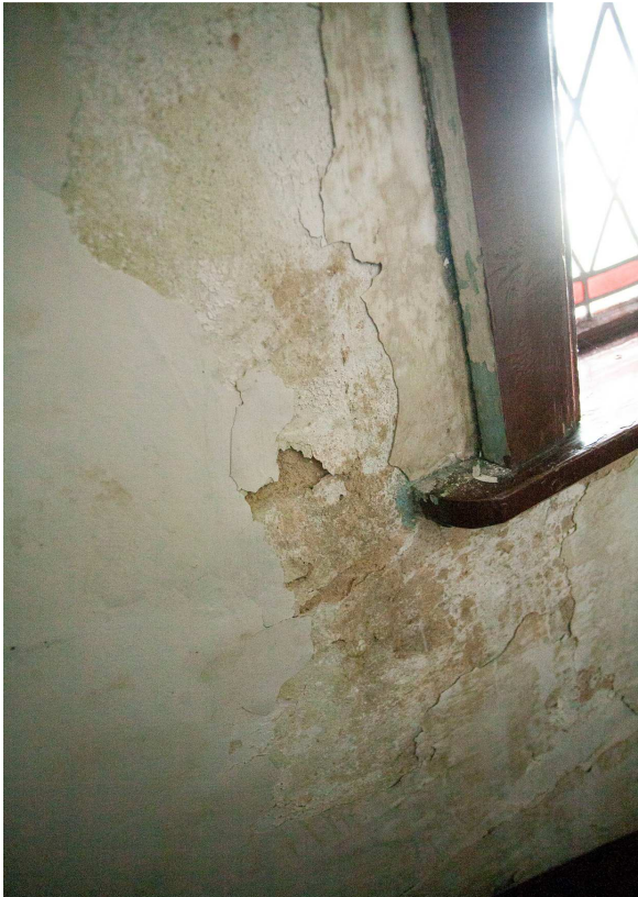
Feuchteschäden gemauerte Innenwände, 2014 (Foto: Monument Service)
