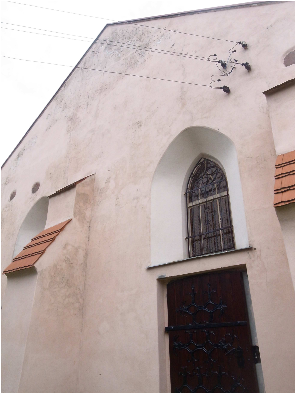
Nordfassade Sakristei vor Instandsetzung, September 2013
