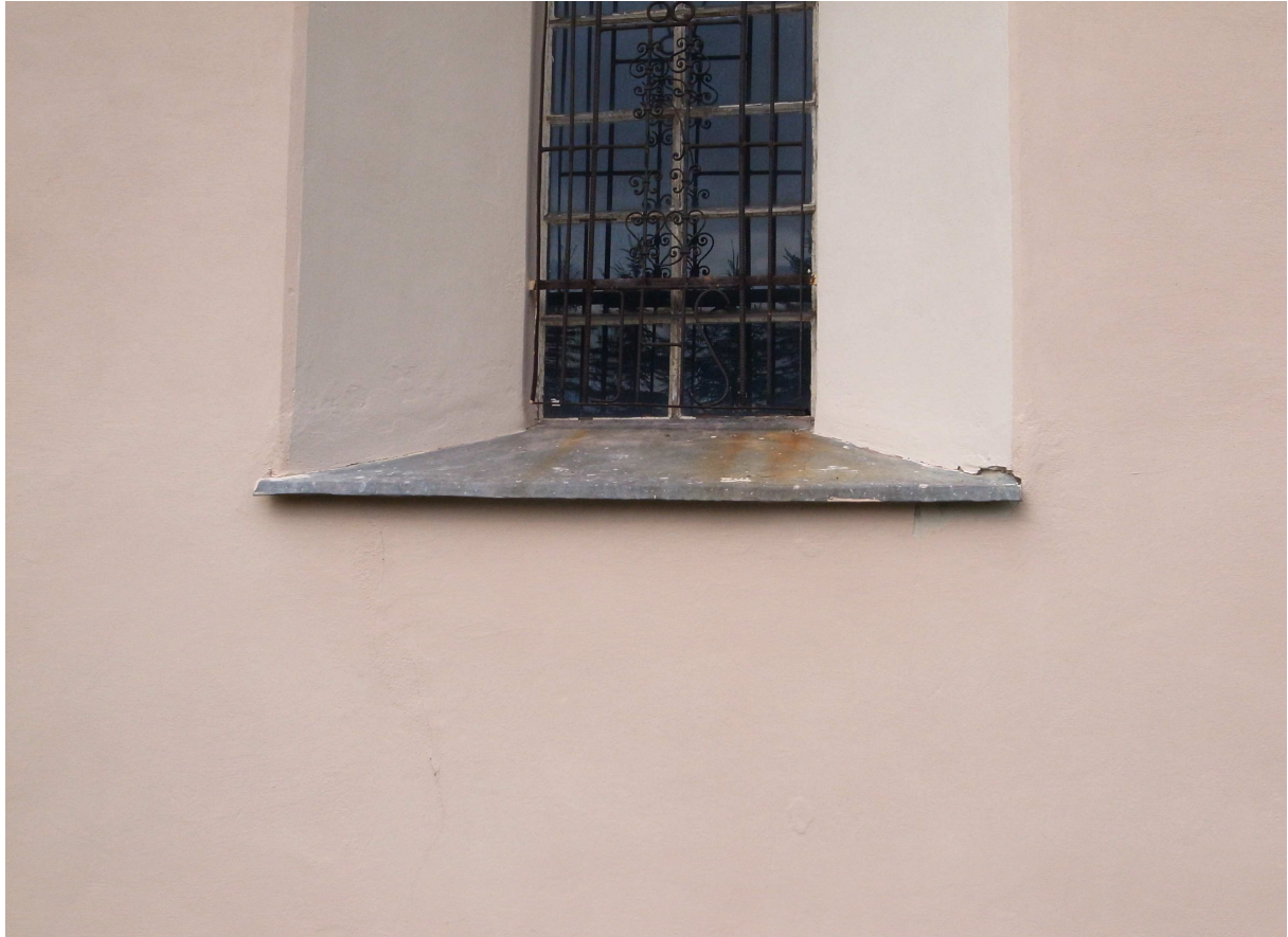
Ausschnitt Südfassade nach der Putzreparatur, August 2014 (Foto Kirchengemeinde)
