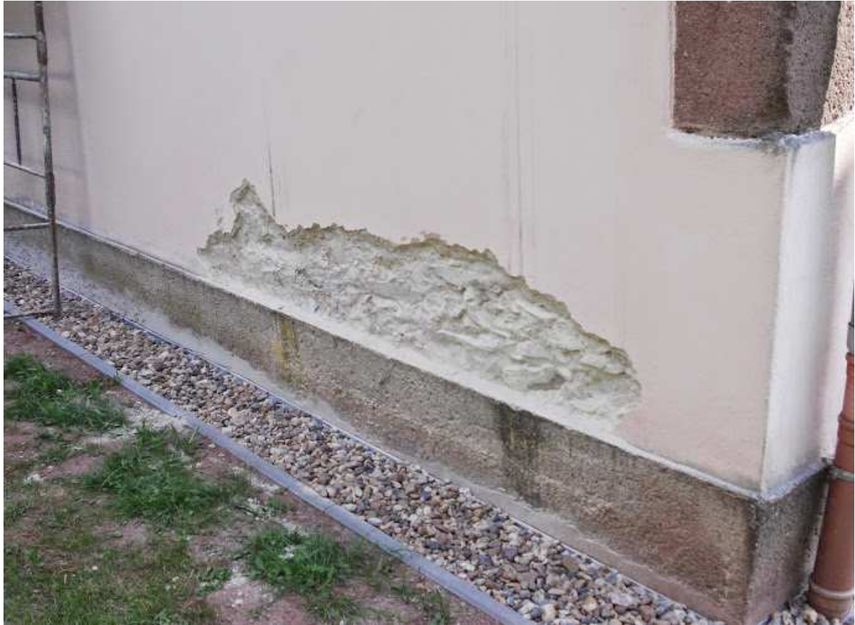
Ausschnitt Ostfassade ehem. Gruftkapelle vor der Reparatur, September 2013
