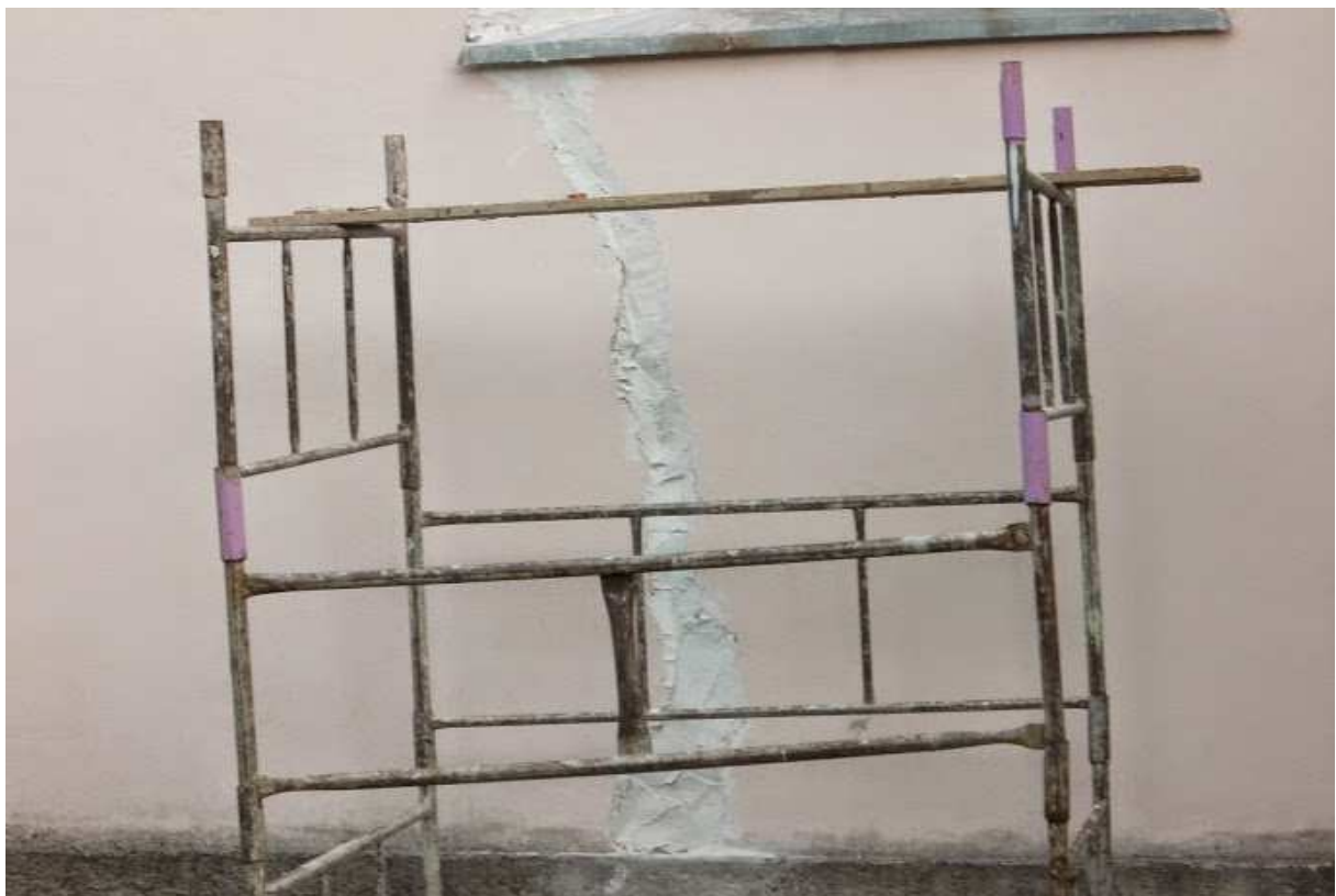
Ausschnitt Südfassade während der Reparatur, Juli 2014 (Foto Kirchengemeinde)
