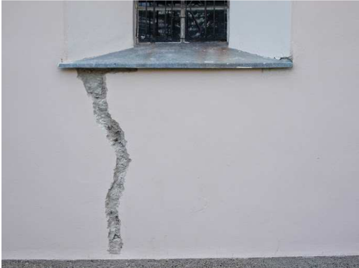
Ausschnitt Südfassade vor Instandsetzung, Juni 2014 (Foto Kirchengemeinde)
