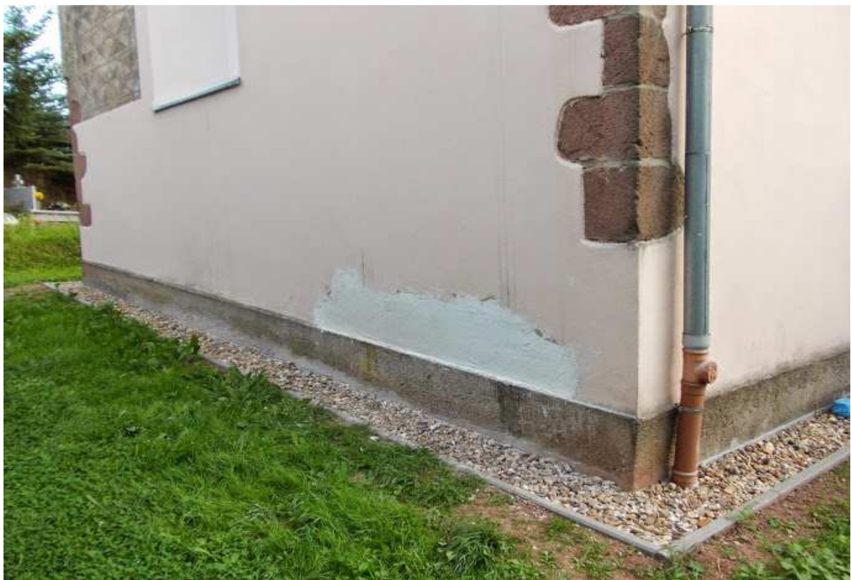
Ausschnitt Ostfassade ehem. Gruftkapelle in Arbeit, Juli 2014 (Foto Kirchengemeinde)
