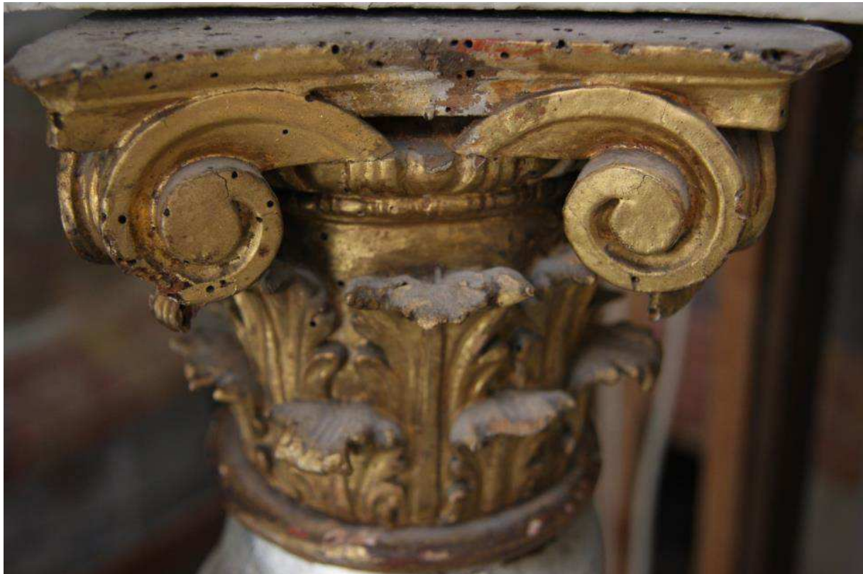
Ehem. Klosterkirche, Hauptaltar, Tabernakel, holzgeschädigtes Kapitell, Sommer 2014 (Foto: Monument Service)
