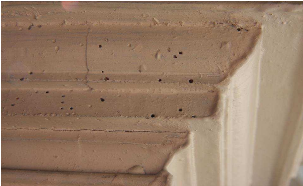
Ehem. Klosterkirche, Hauptaltar, Tabernakel, Holzwicklerbefall, Herbst 2014 (Foto: Monument Service)
