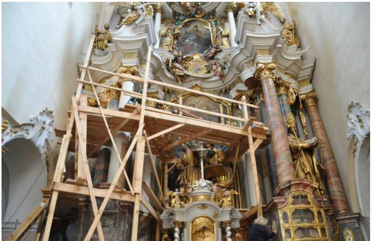
Ehem. Klosterkirche, eingerüsteter Hauptaltar, Sommer 2014 (Foto: Monument Service)
