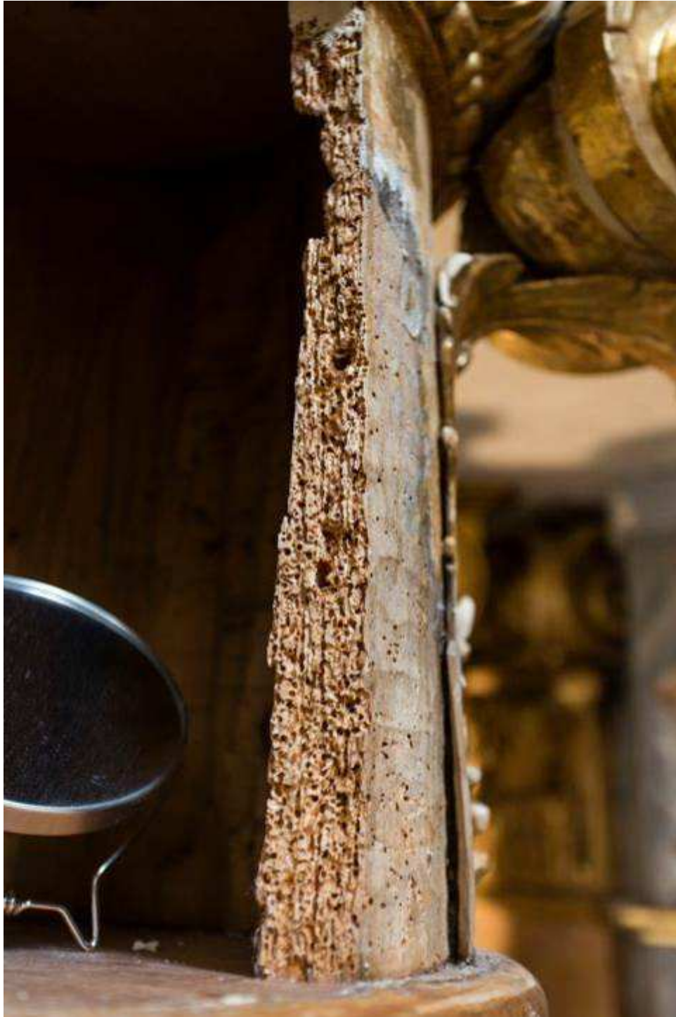
Ehem. Klosterkirche, Hauptaltar, Tabernakel, Holzwurmbefall, Herbst 2014
