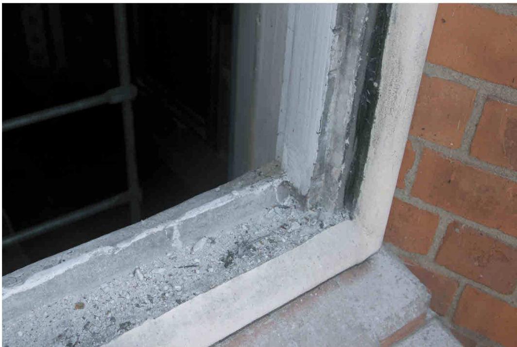
Fot..177-179. Zdjęcia wykonane w trakcie demontażu, październik 2014
