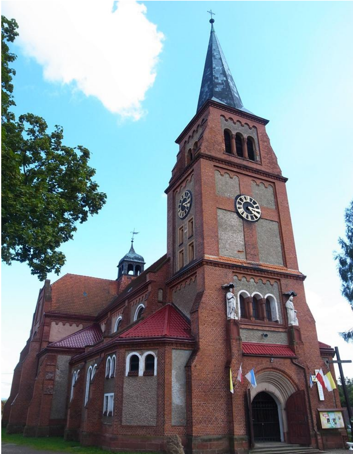
Niedersteine / Ścinawka Dolna, Kath. Pfarrkirche d.Hl. Jakobus d.Ä.,Nordwestansicht, August 2012
