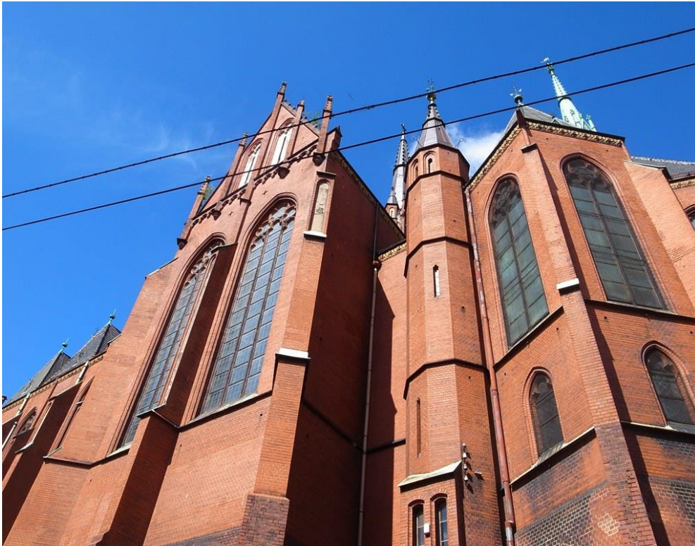
Waldenburg / Wałbrzych, Kath. Schutzengelkirche, südöstliche Teilansicht, August 2012
