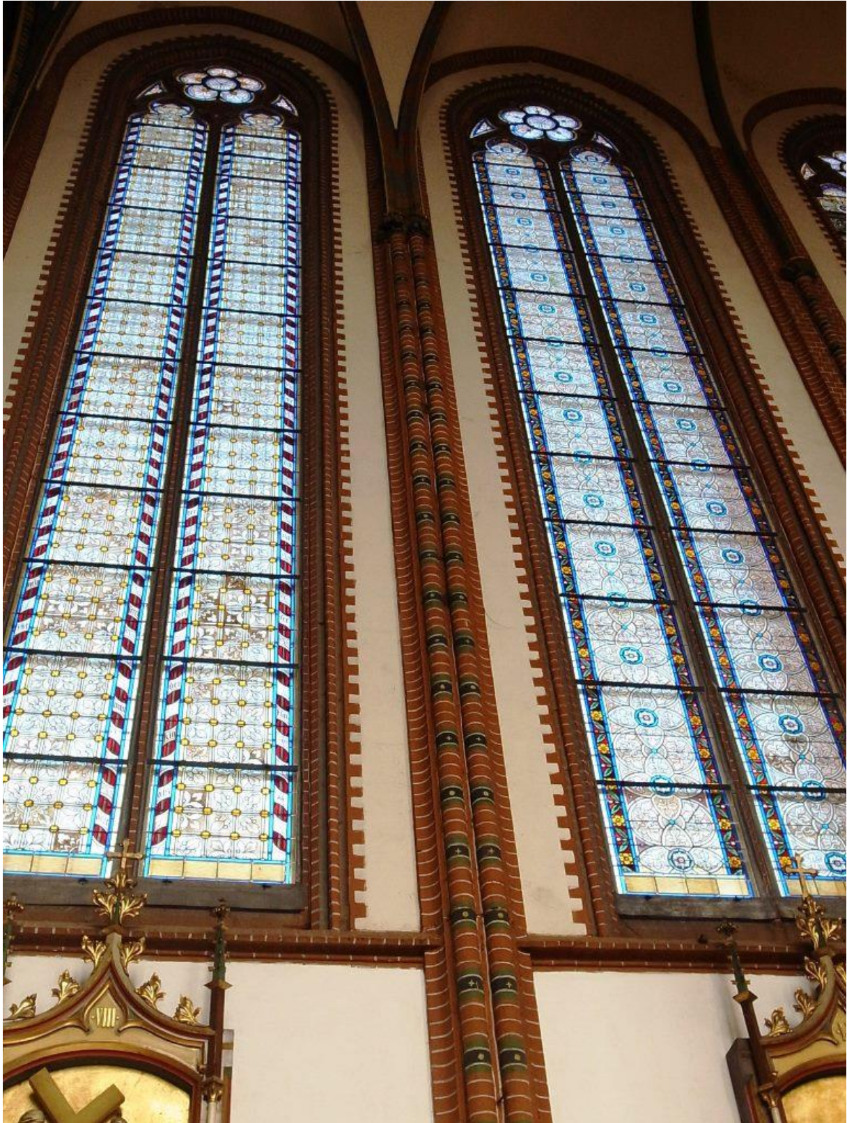
Waldenburg / Wałbrzych, Kath. Schutzengelkirche, zwei im Zuge vorangegangener Restaurierungsarbeiten instand gesetzte Fenster der Kirchenschiff-Nordseite, August 2012
