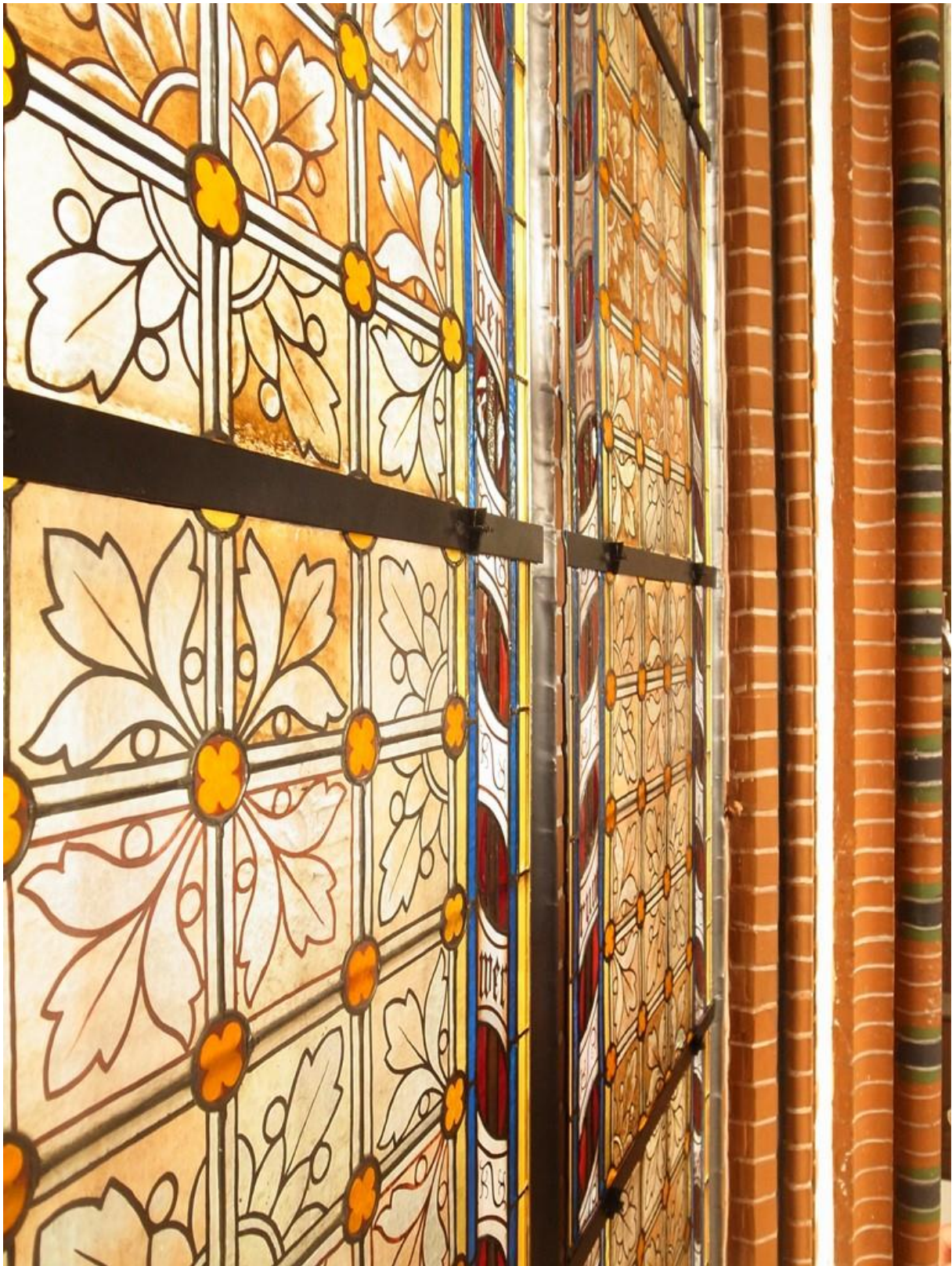
Waldenburg / Wałbrzych, Kath. Schutzengelkirche, Nordseite, Ausschnitt restauriertes östliches Fenster, Herbst 2013
