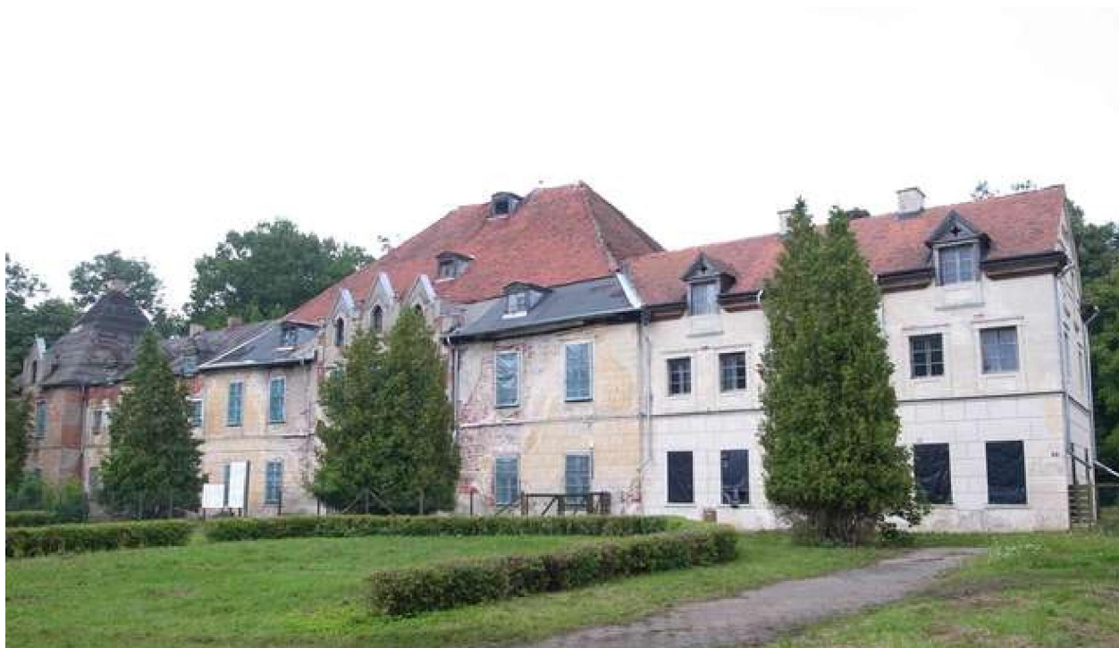
Pałac w Sztynorcie przed rozpoczęciem prac remontowych
