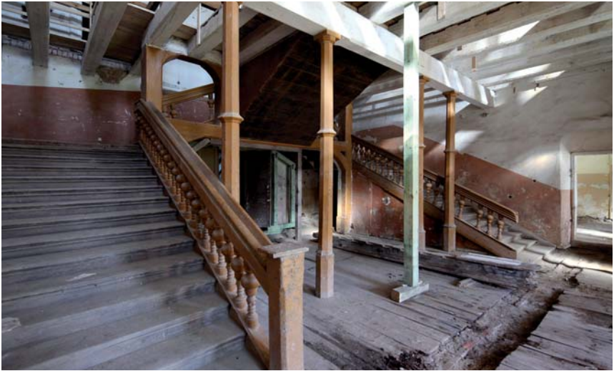
Doppelläufige Treppe im Foyer
