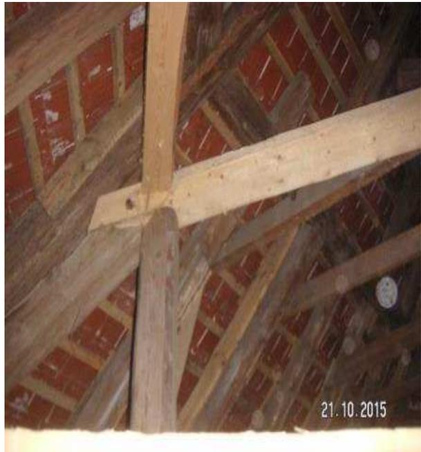
Teil-Bauabschnitt 2015: li. geöffnete Emporeseite u. re. Ausgetauschter Dachstuhlbalken, Okt. 2015
