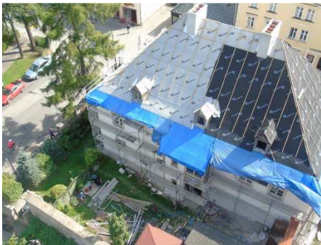
Dachaufsicht mit neu gemauerten Schornsteinköpfen und rechts mit zusätzlich angebrachten neuen Öffnungen, jeweils Spätsommer 2014 Fotos: K. Ałykow)
