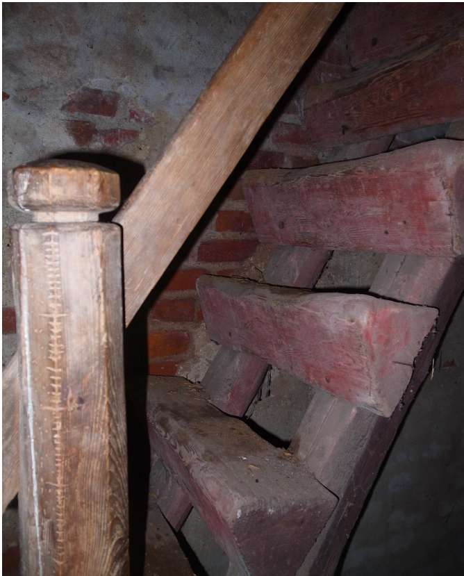
Holztreppe in den Turmdachstuhl, Februar 2013
