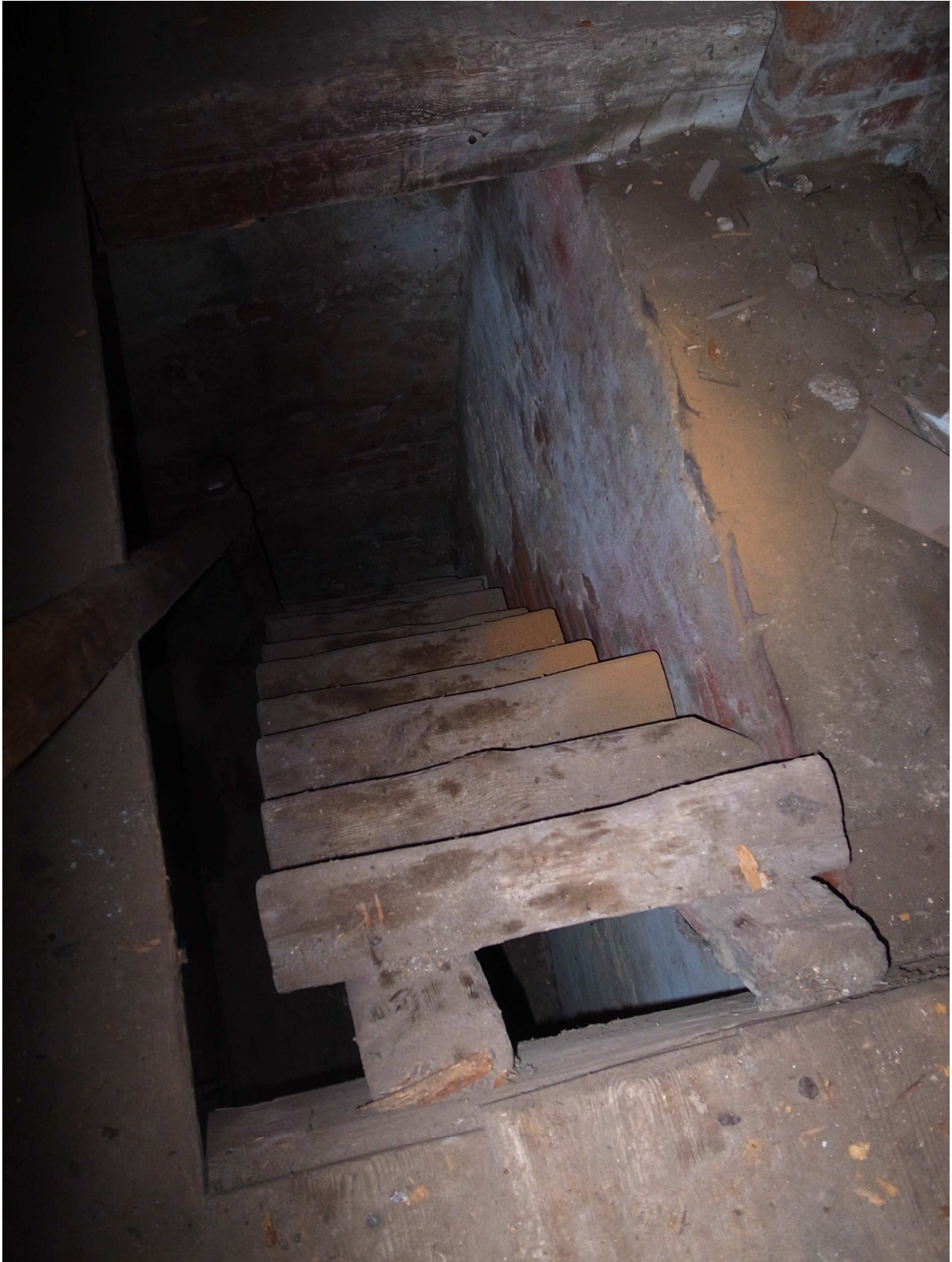
Holztreppe in den Turmdachstuhl, Februar 2013
