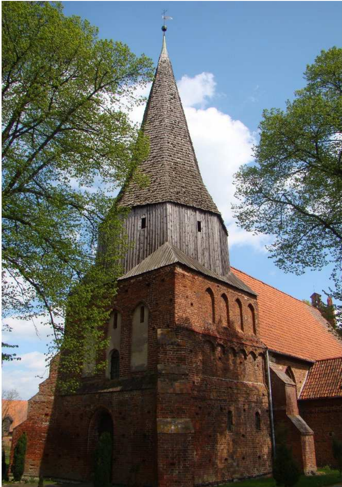
Turm vor der Instandsetzung (Foto: A. Lewicki)
