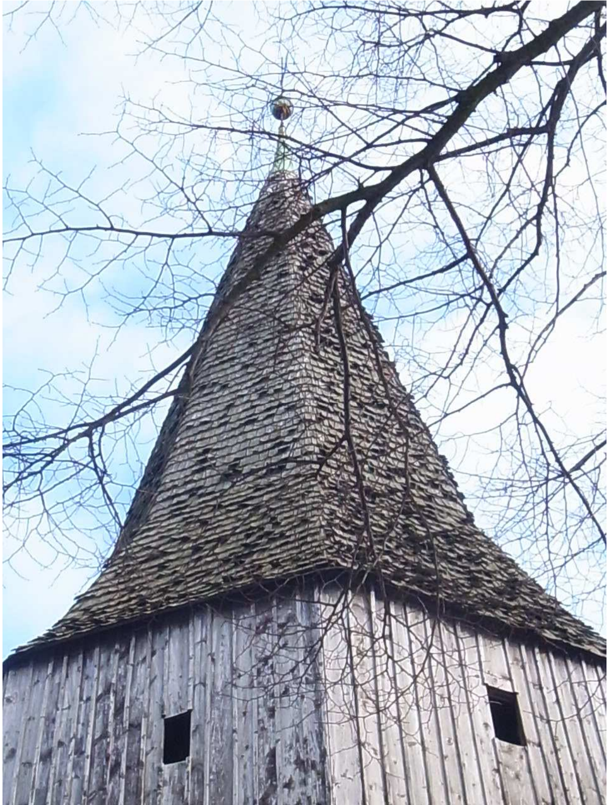
Turmhelm vor Instandsetzung, Februar 2013
