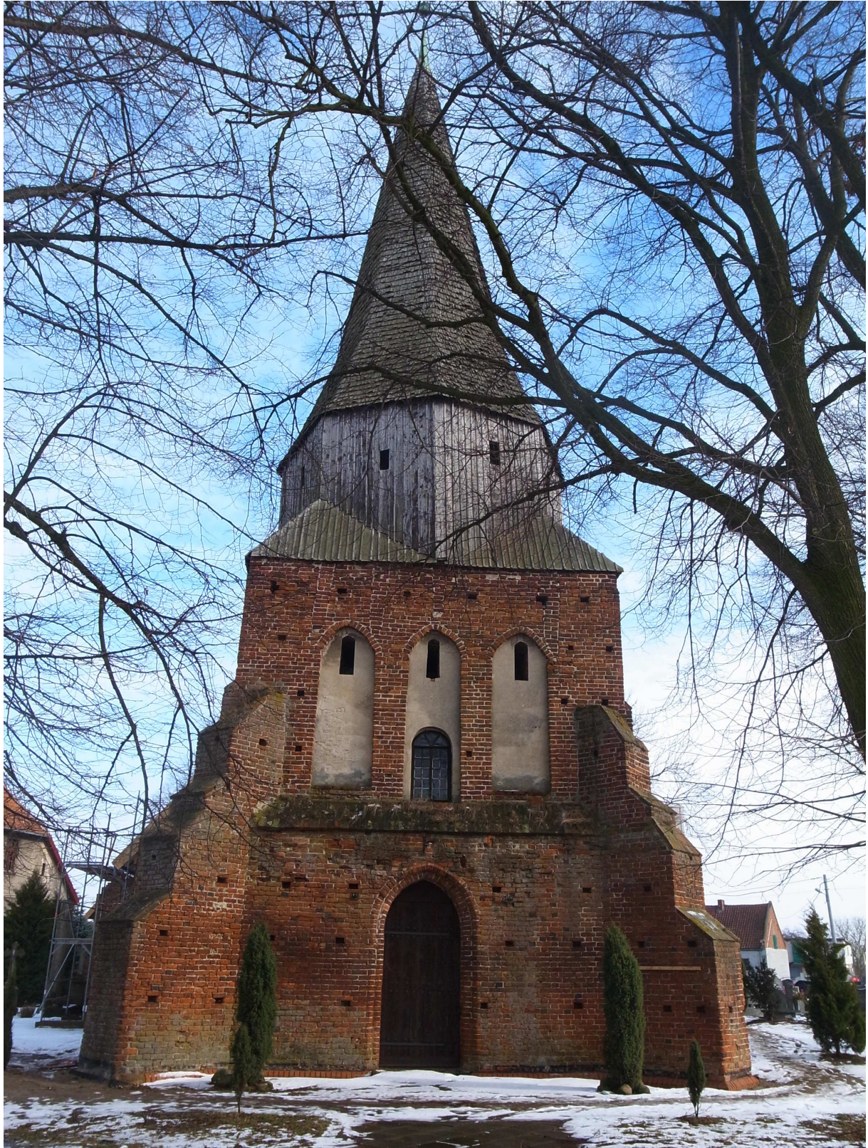
Westansicht Turm vor der Instandsetzung, Februar 2013
