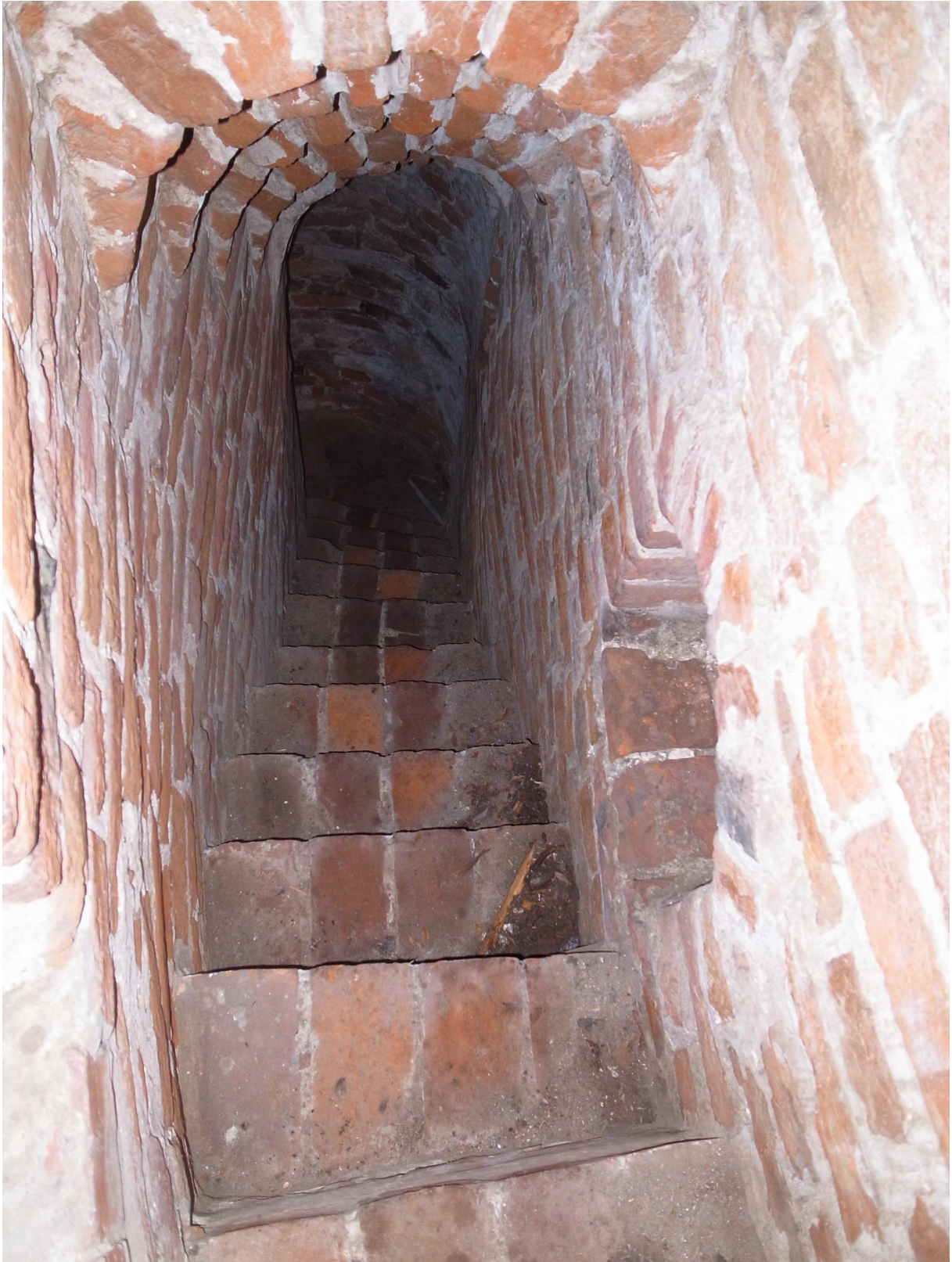
Turmtreppe massiver Teil, Februar 2013
