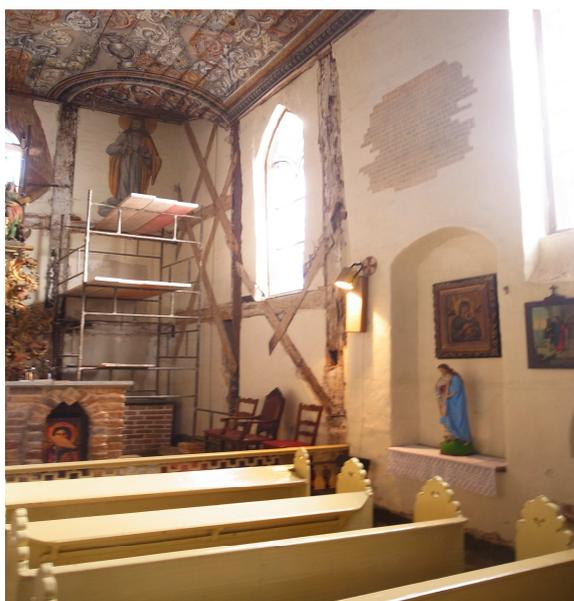
Freigelegte Fachwerkkonstruktion Schiff-Südwand, Februar 2013
