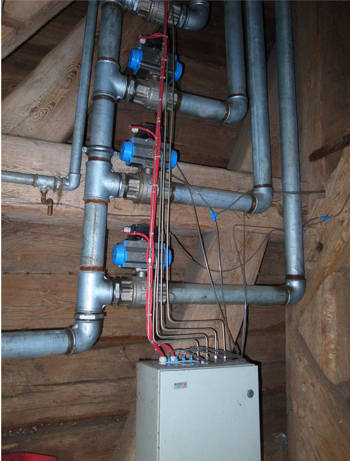
Hinter der Laube Nordseite Schiff installierte Wassernebelanlage. Frühjahr 2012
