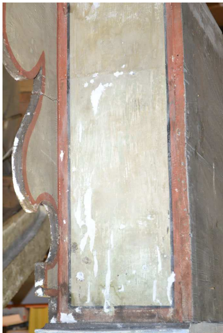
Altarmensa nach Verkittung Schadlöcher, 2013
