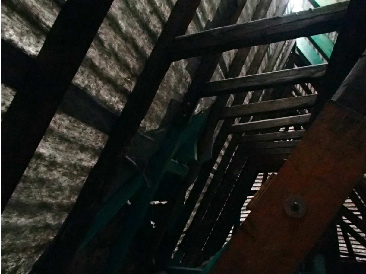
Ausschnitt Dachstuhl Langhaus nach der Reparatur, Foto: K. Atykow, Spätsommer 2013
