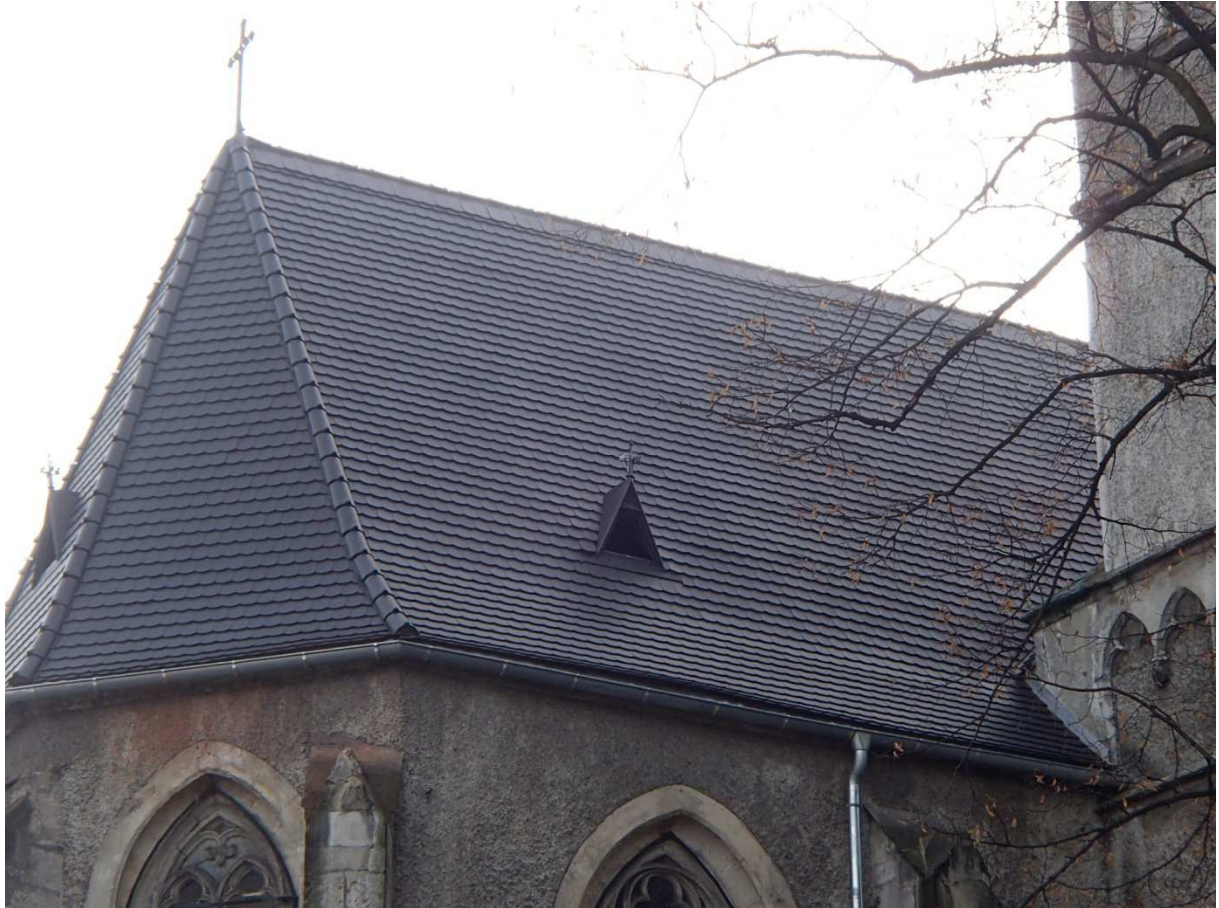
Ausschnitt neu gedeckte Nordostseite Langhausdach, Foto: K. Atykow, Herbst 2013
