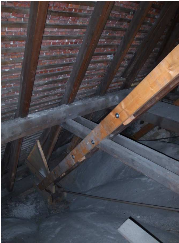
Ausschnitt Dachstuhl Langhaus mit jüngerer Verstärkung (vor der Sanierung), Sommer 2013
