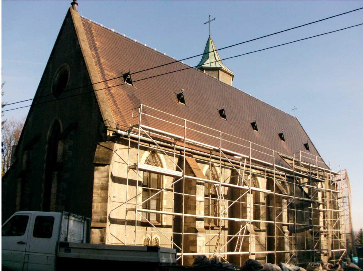
Neueingedeckte Dachsüdseite noch mit rotem Ziegelstaub bedeckt, Foto: C. Królewicz, Herbst 2013
