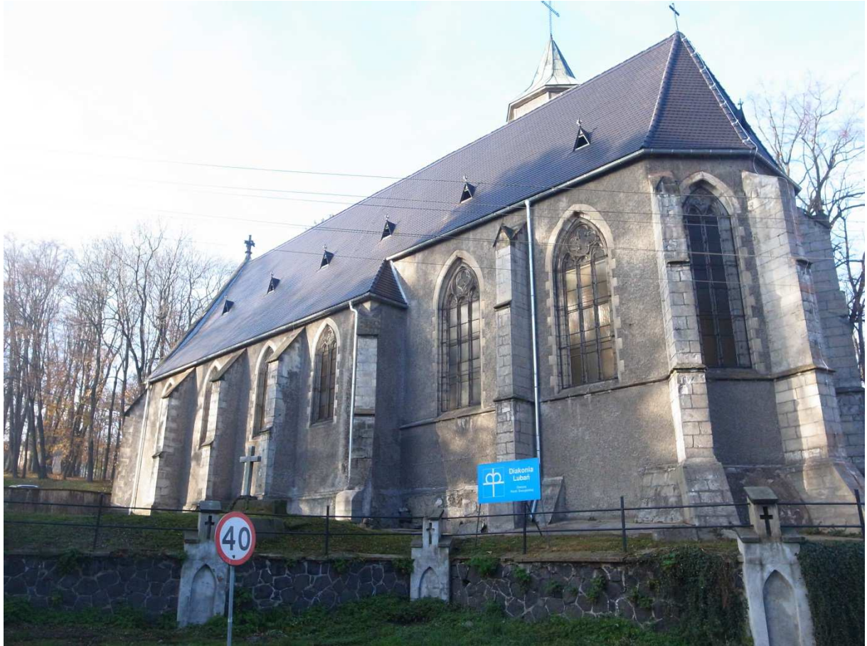
Südostansicht mit neu gedecktem Dach, November 2013
