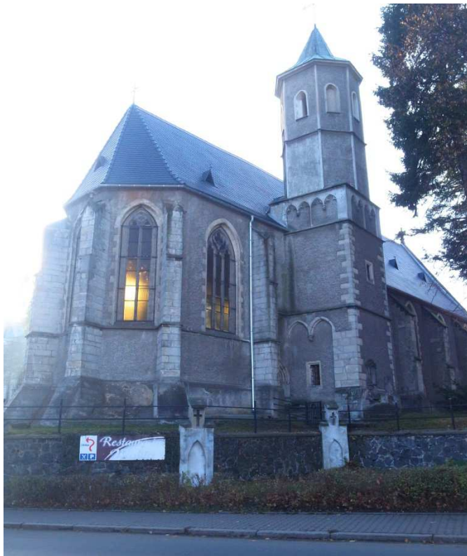
Nordostansicht mit neu gedecktem Dach, November 2013
