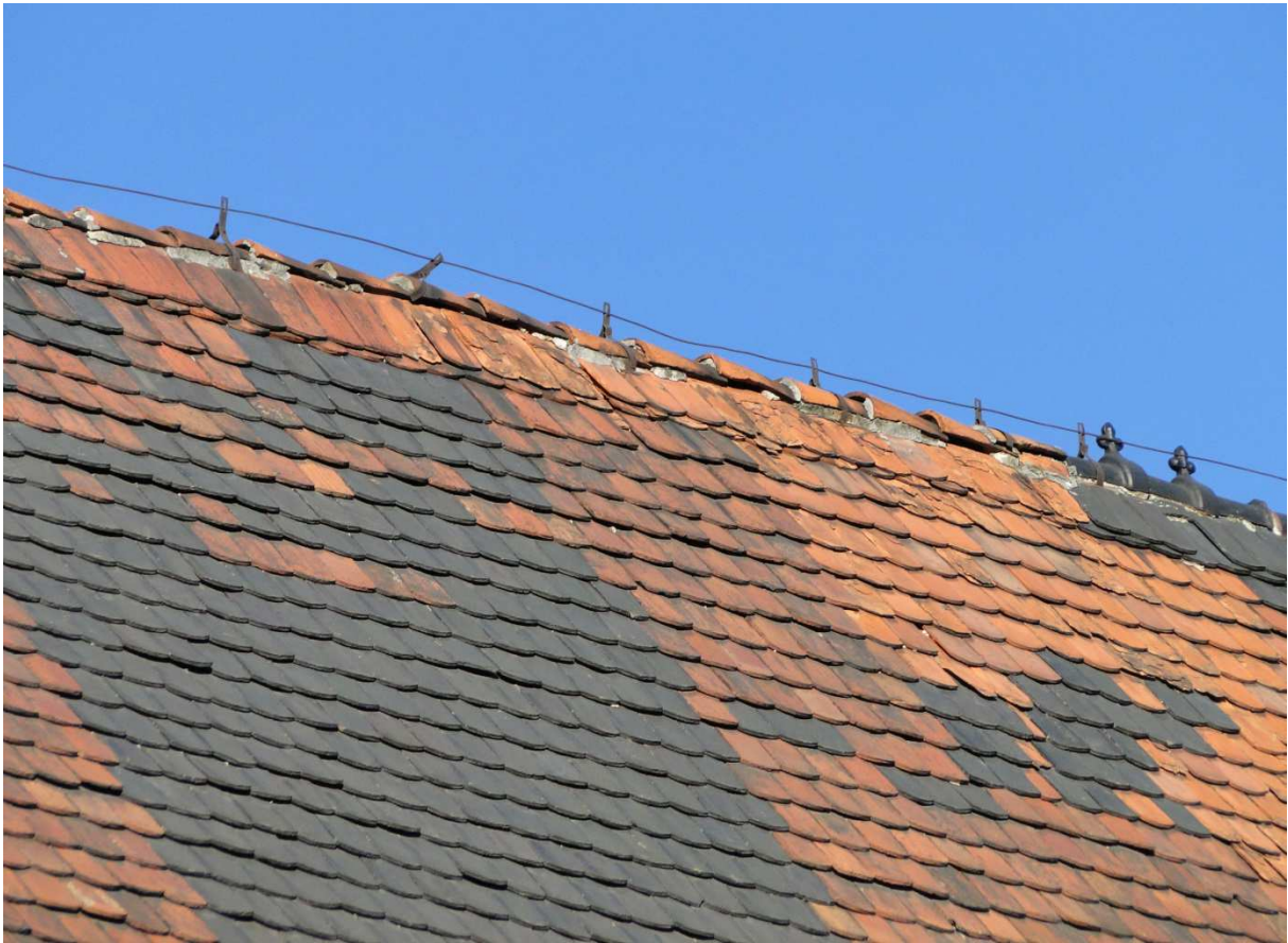
Firstzone Langhausdachdach von Süden vor der Sanierung, Foto: K. Atykow, 2012
