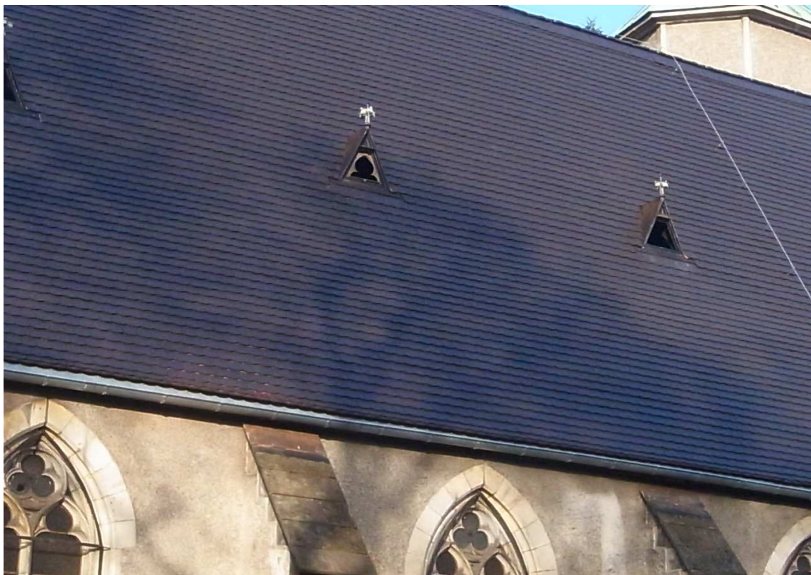
Ausschnitt neu gedeckte Südseite Langhausdach, November 2013
