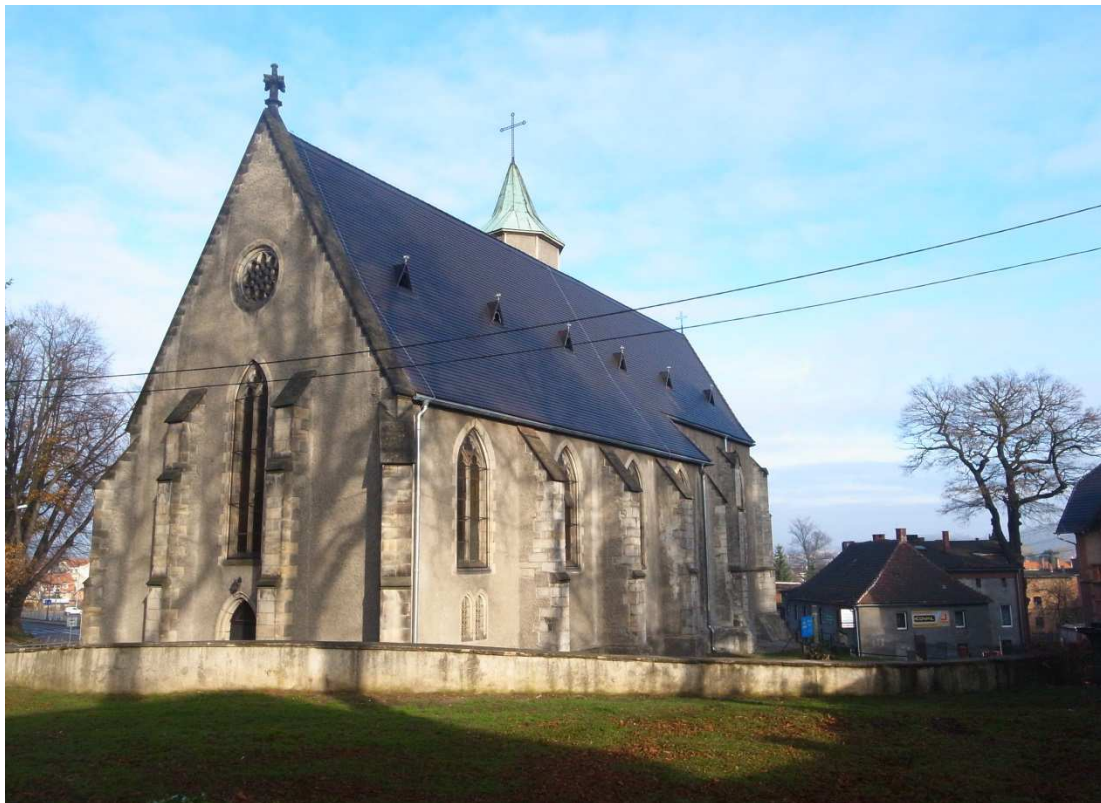
Südwestansicht mit neu gedecktem Dach, Foto: November 2013
