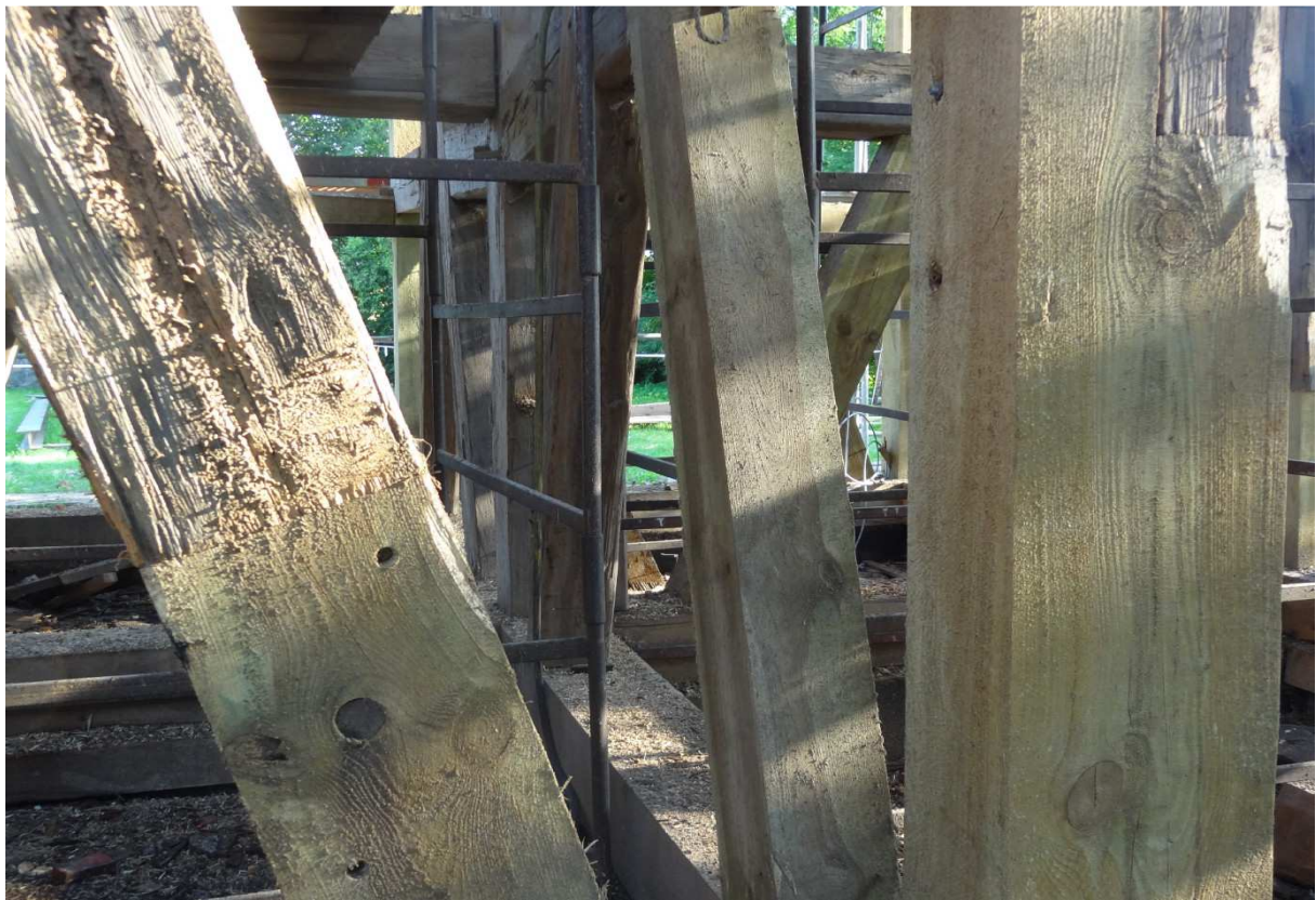
Instandgesetzte Turmkonstruktion, Spätsommer 2014 (Foto: Kirchengemeinde Sławęcın)
