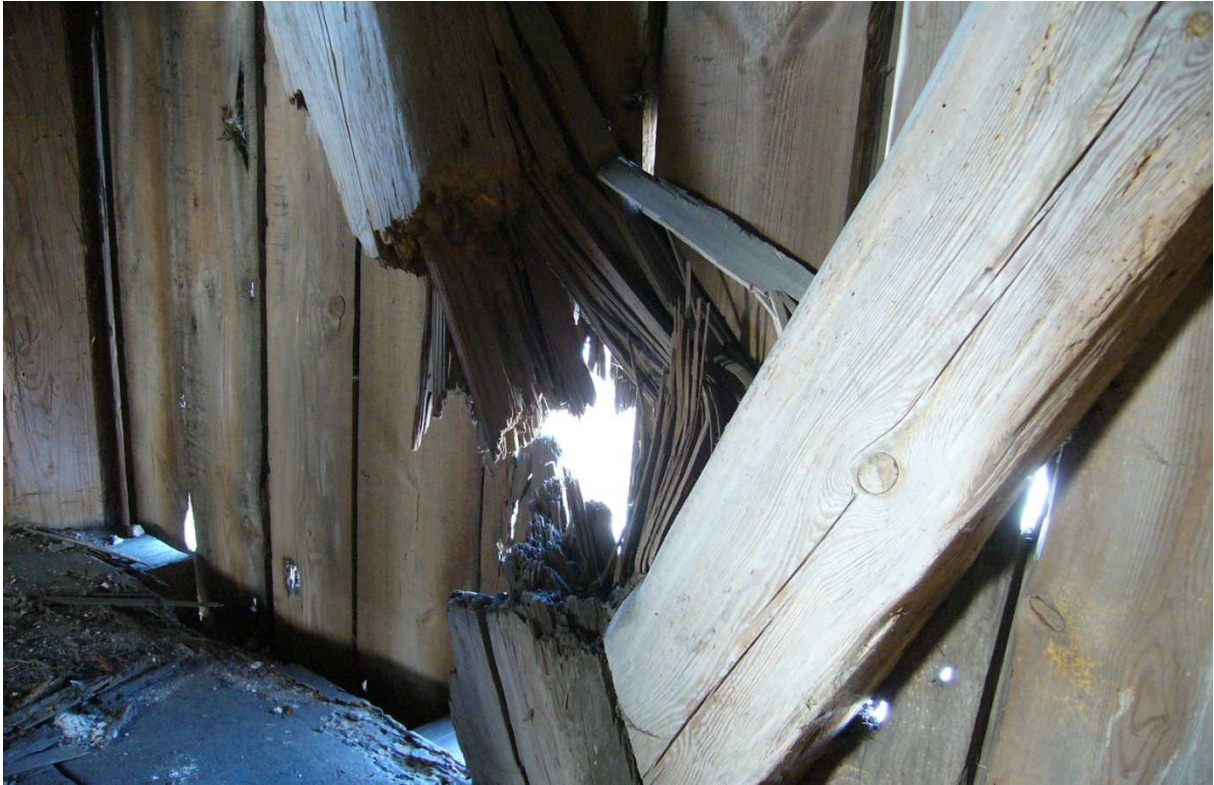
Geschädigte Holzverschalung Turm vor Instandsetzung (Foto Kirchengemeinde Sławęcín)
