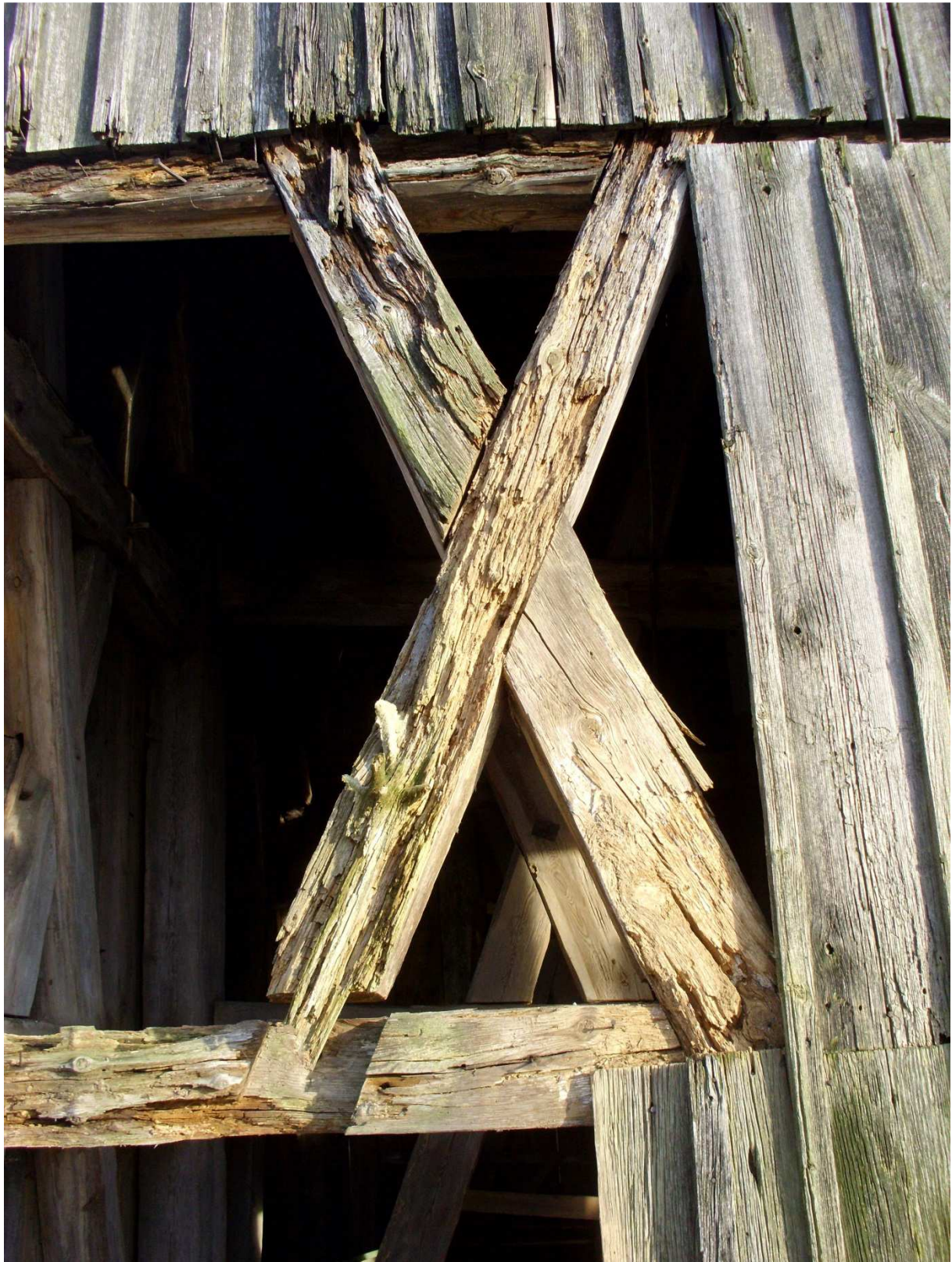
Geschädigte Turmkonstruktion vor Instandsetzung, 2013 (Foto Kirchengemeinde Sławęcın)
