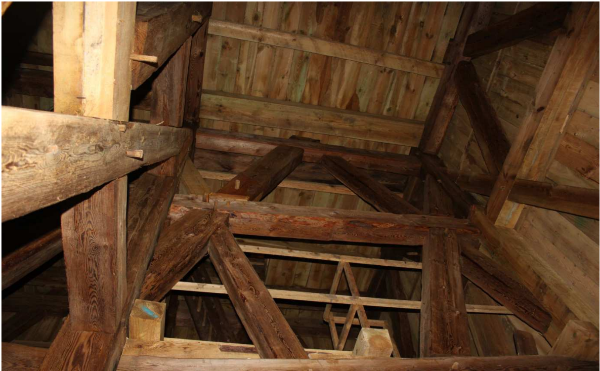
Turm innen nach Instandsetzung, Januar 2015
