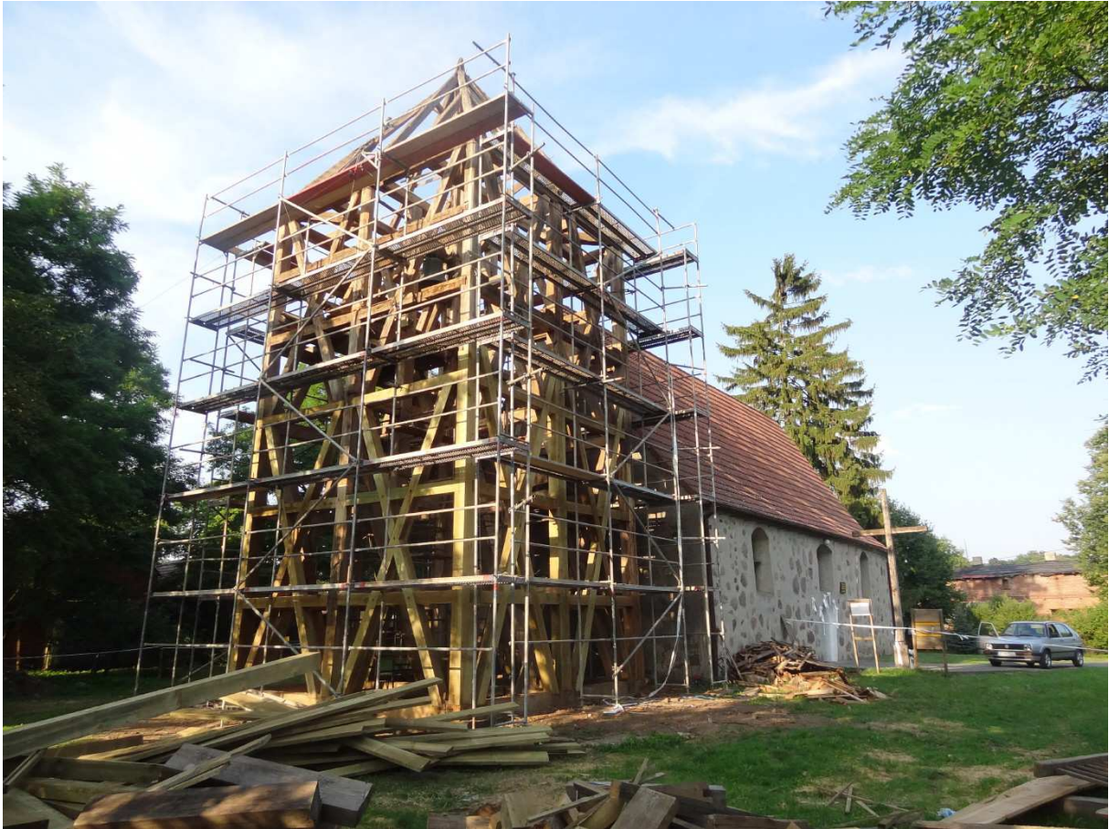
Einrüstung Holzturm, August 2014 (Foto: Kirchengemeinde Sławęcín)
