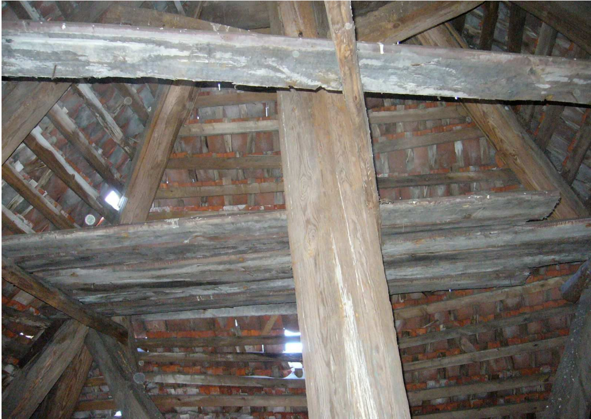
Innenansicht verschlissene Turmeindeckung vor Sanierung; November 2013
