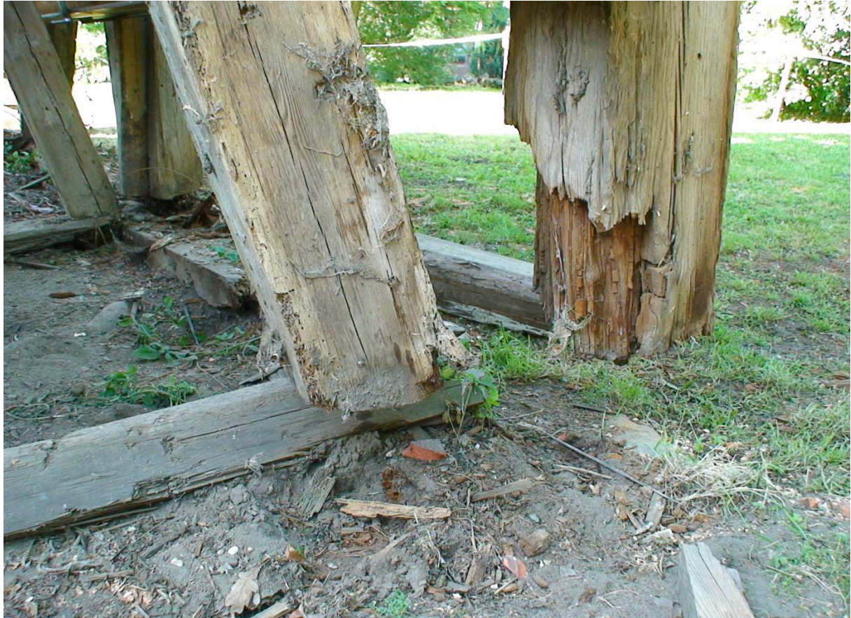
Verfaulte Fußpunkte Turmkonstruktion, Juli 2014 (Foto: Kirchengemeinde Sławęcın)
