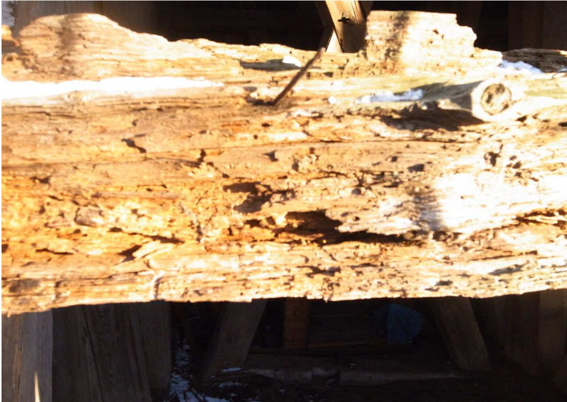
Morsches Konstruktionselement Holzturm, November 2013
