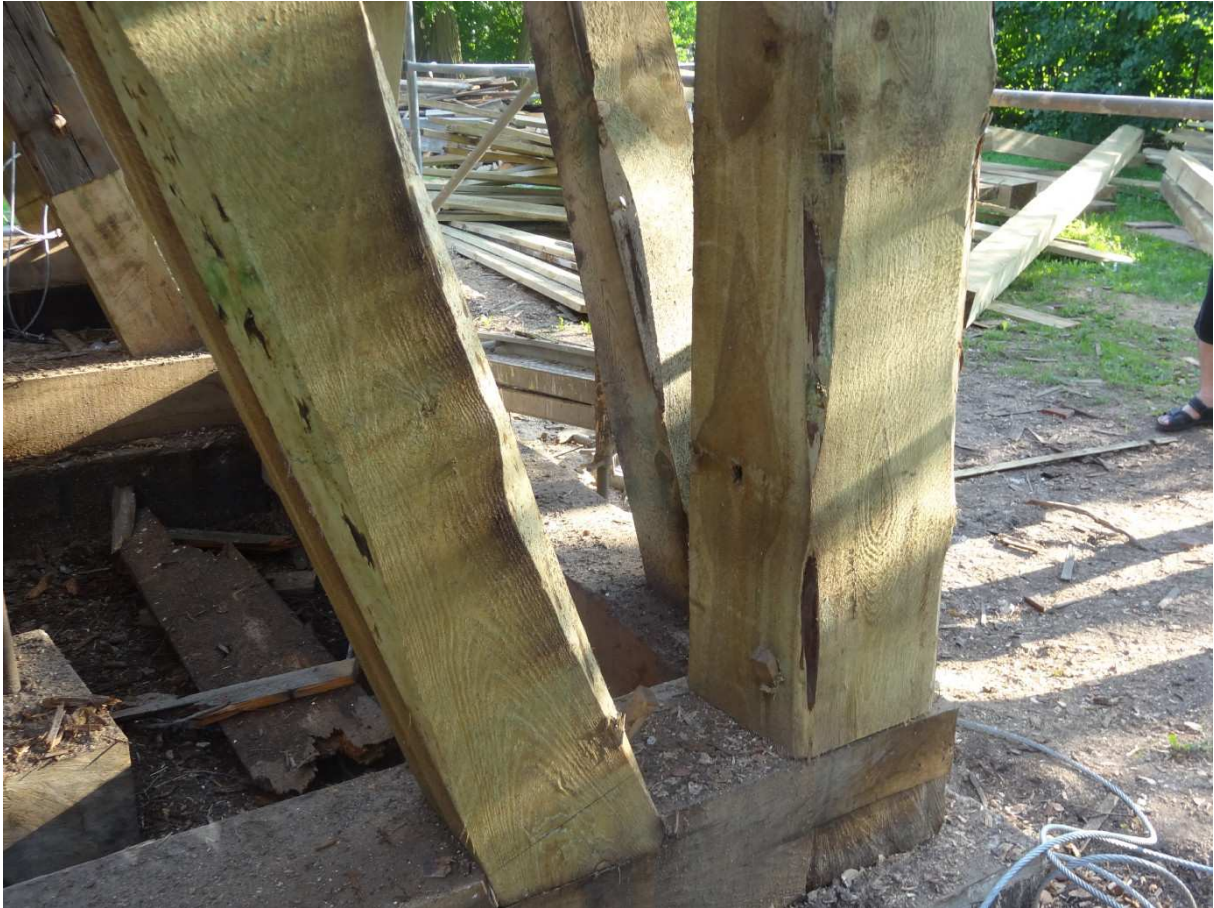
Instandgesetzte Fußpunkte Turmkonstruktion, Spätsommer 2014 (Foto: B. Makowska)
