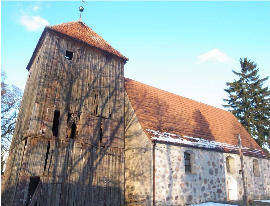
Südansicht Kirche vor der Turminstandsetzung, 2013 (Foto Kirchengemeinde Sławęcín)
