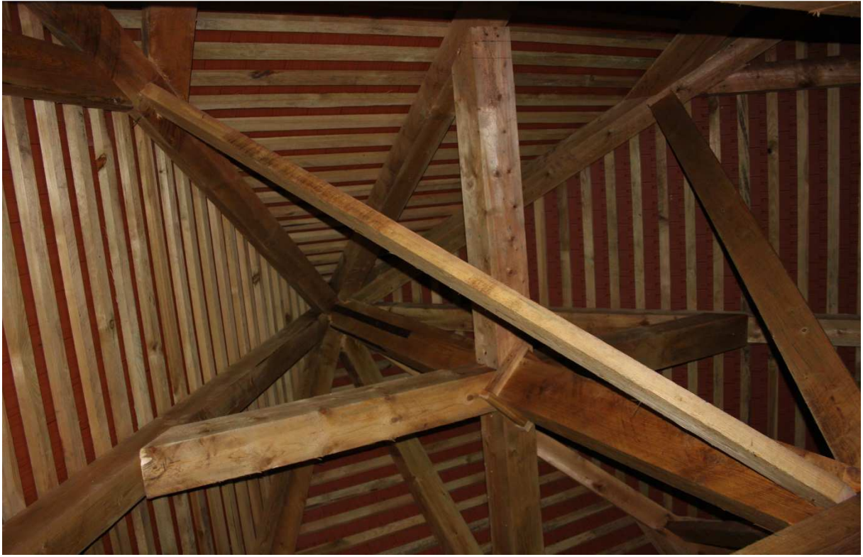
Neue Ziegeldachdeckung Turm von innen, Januar 2015
