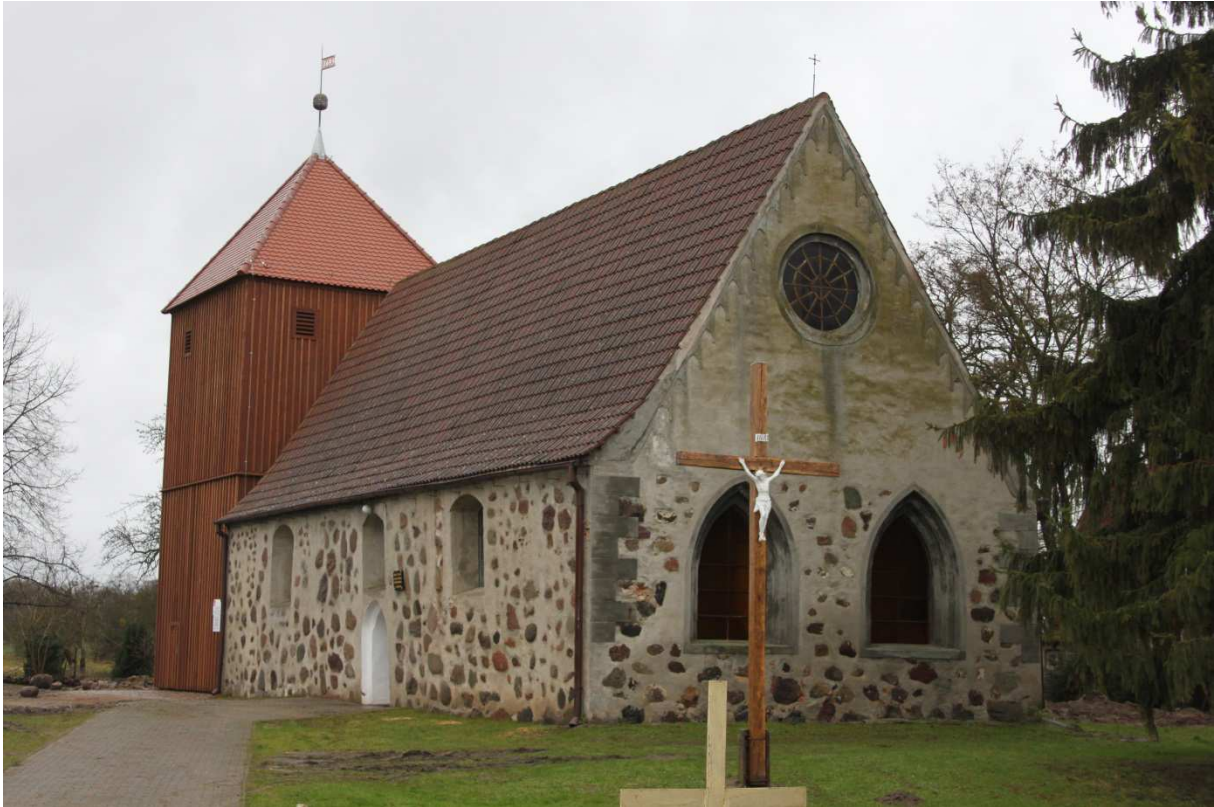
Gesamtansicht Kirche von Südosten nach Turminstandsetzung, Januar 2015
