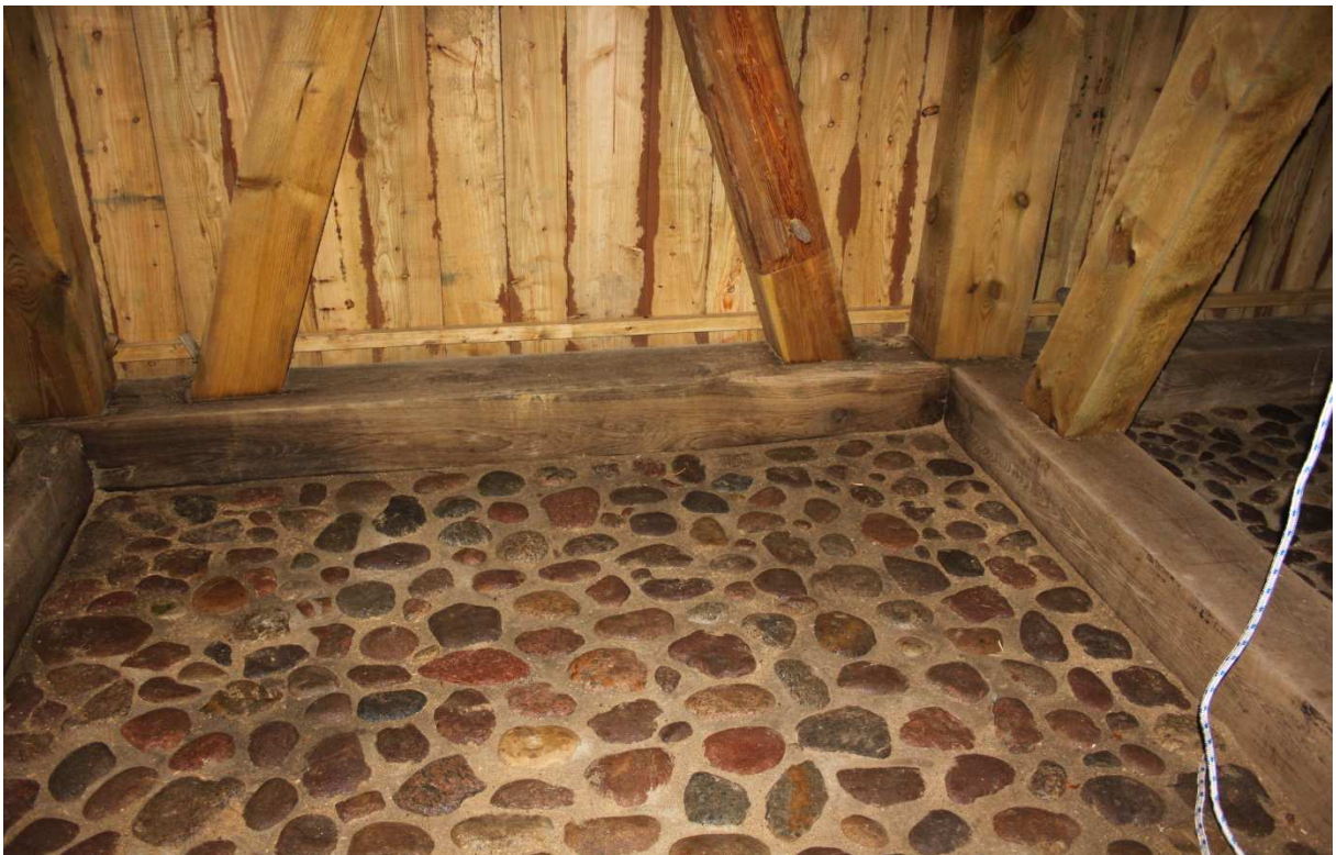
Neue Holzverschalung und Pflasterung EG-Bereich Turm innen, Januar 2015
