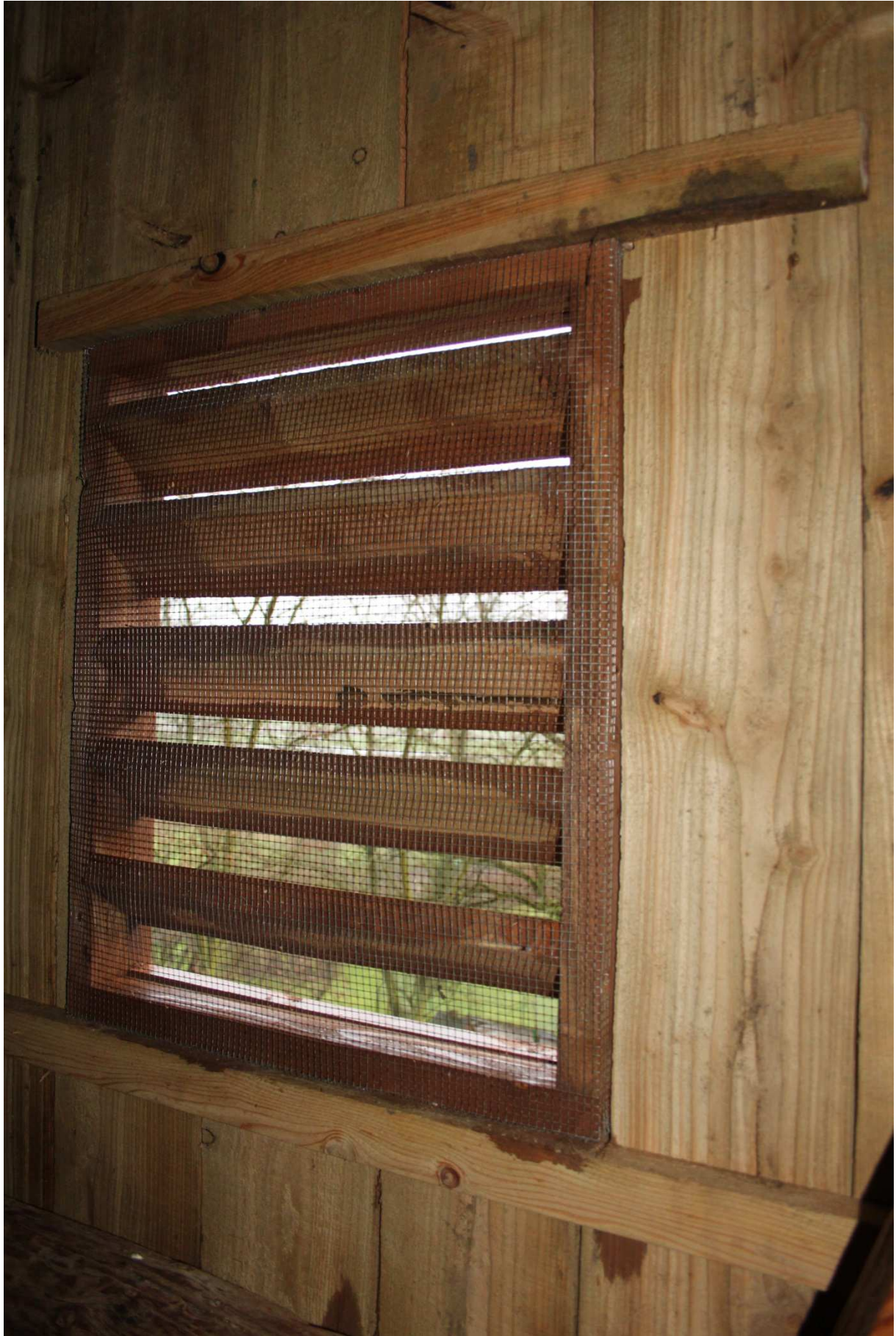
Schallarkade mit neuer Jalousie Glockenstuhlebene Turm, Januar 2015
