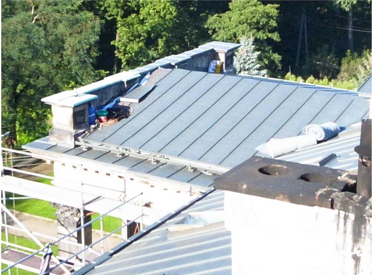
Portikus Südseite mit Neueindeckung in Titanzinkblech, September 2012
