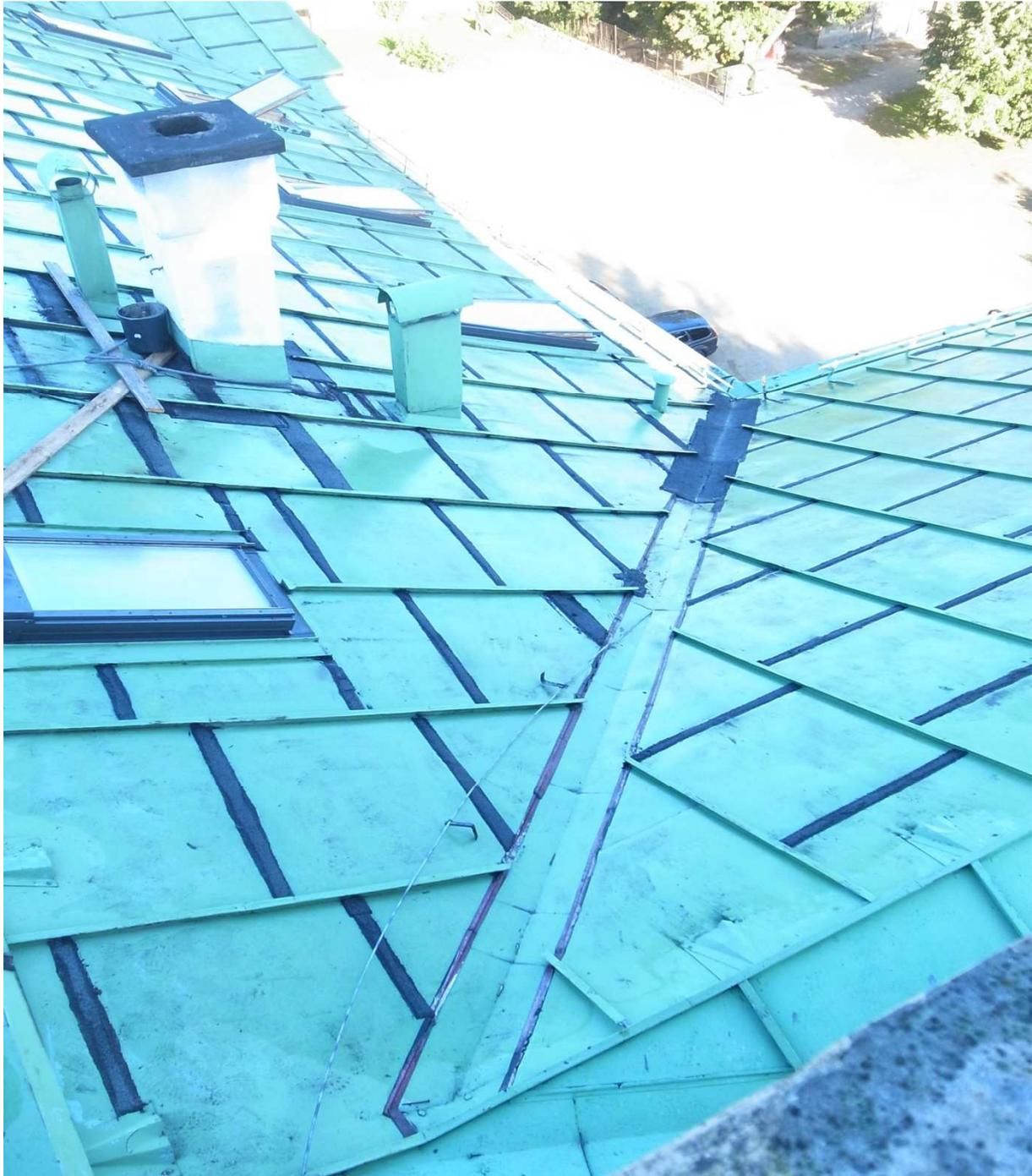
Hauptdach Nordseite mit undichter Metalldeckung, September 2012
