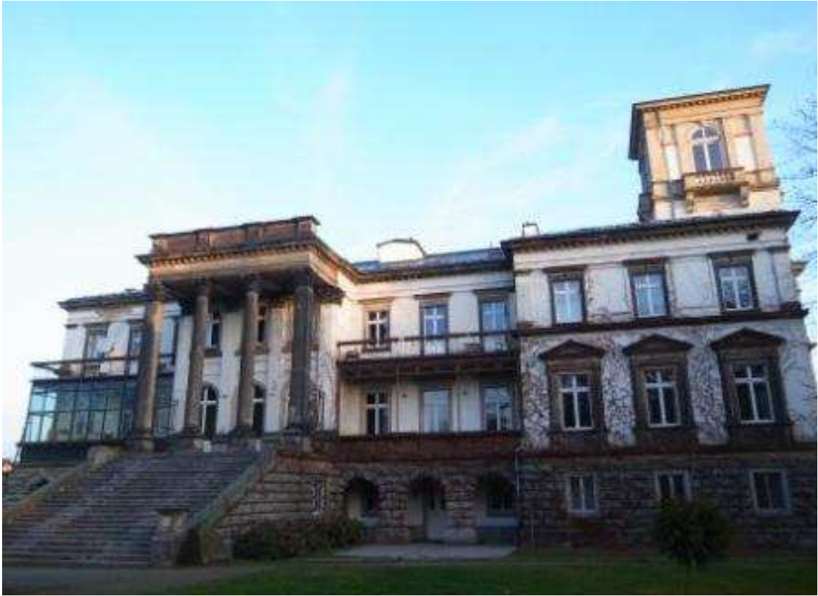
Südfassade nach fertiggestellter Dachinstandsetzung, November 2012
