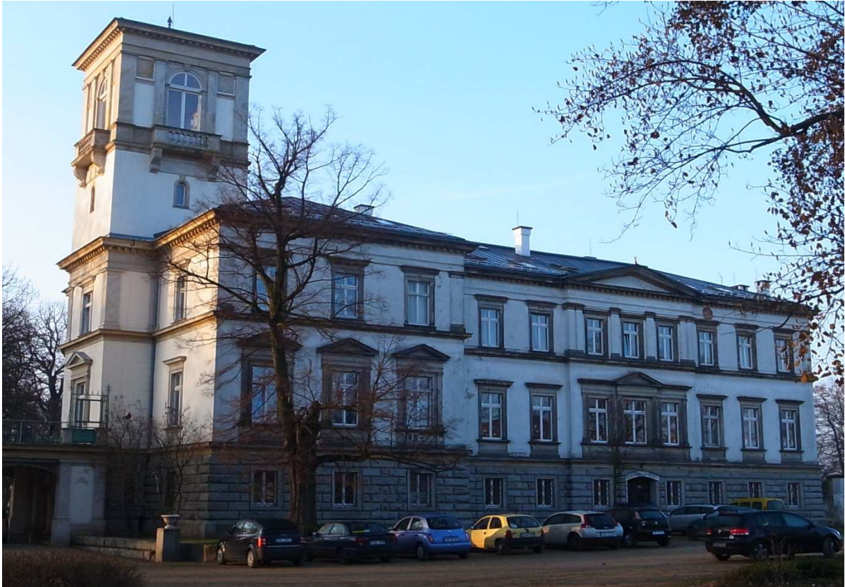
Ansicht Nordfassade, November 2012
