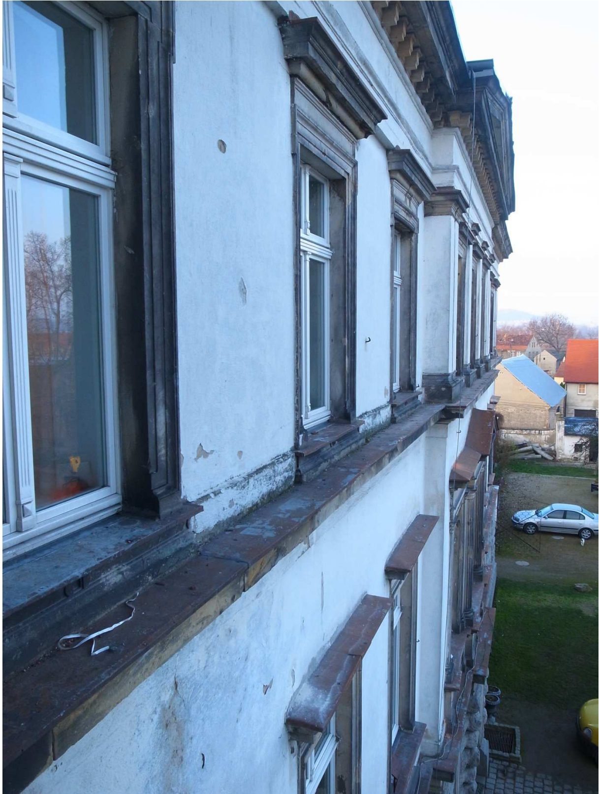
Ausschnitt Nordfassade, November 2012
