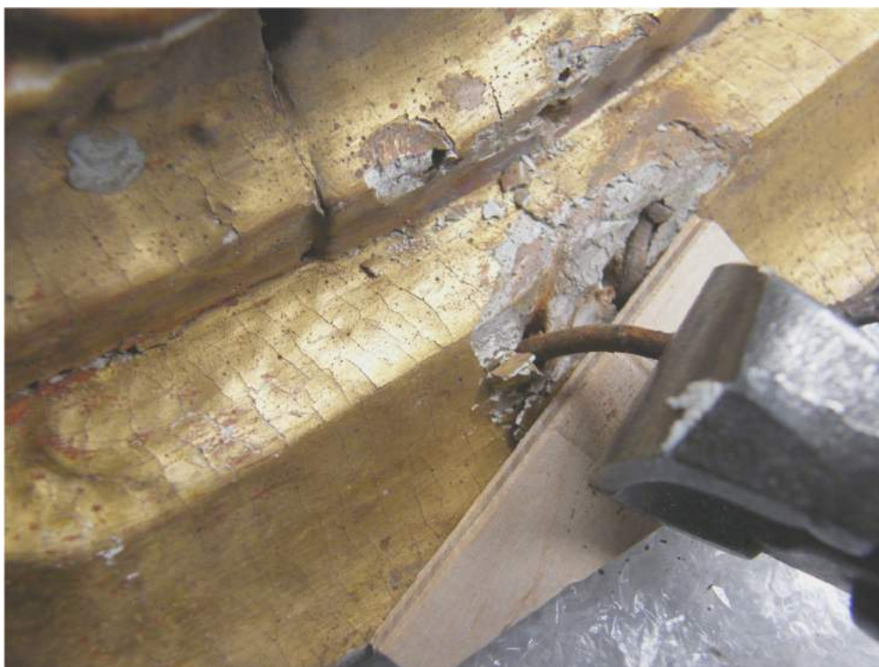
8. Usuwanie elementów obcych z lica profilu ramy.
