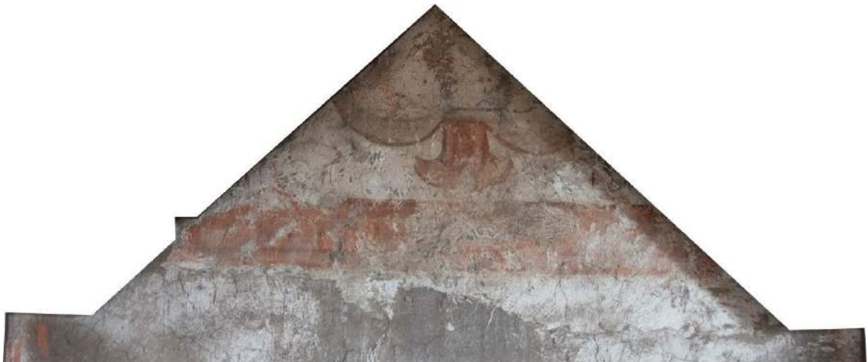
Gościkowo-Paradyż, ołtarz główny. Pole za obrazem z wizerunkiem św. Marcina, Fragment polichromii na ścianie wschodniej prezbiterium. fot. D. Kwiecień, 2017.10.16.
