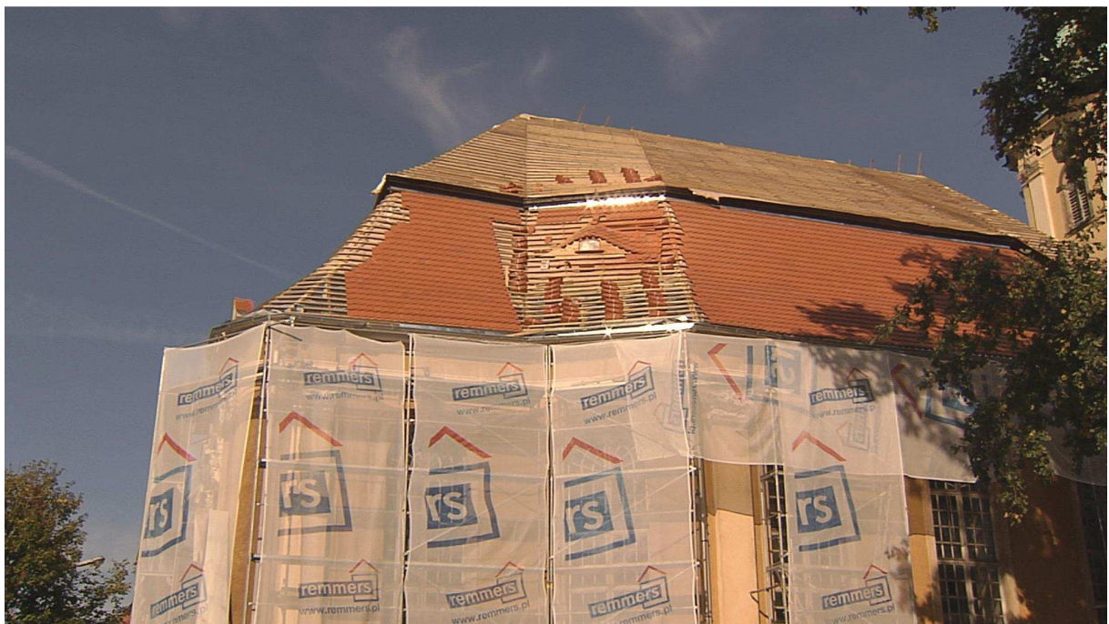
Dachneueindeckung Langhaus, September 2011 (Foto: Havel-Film Babelsberg, H.D. Rutsch)
