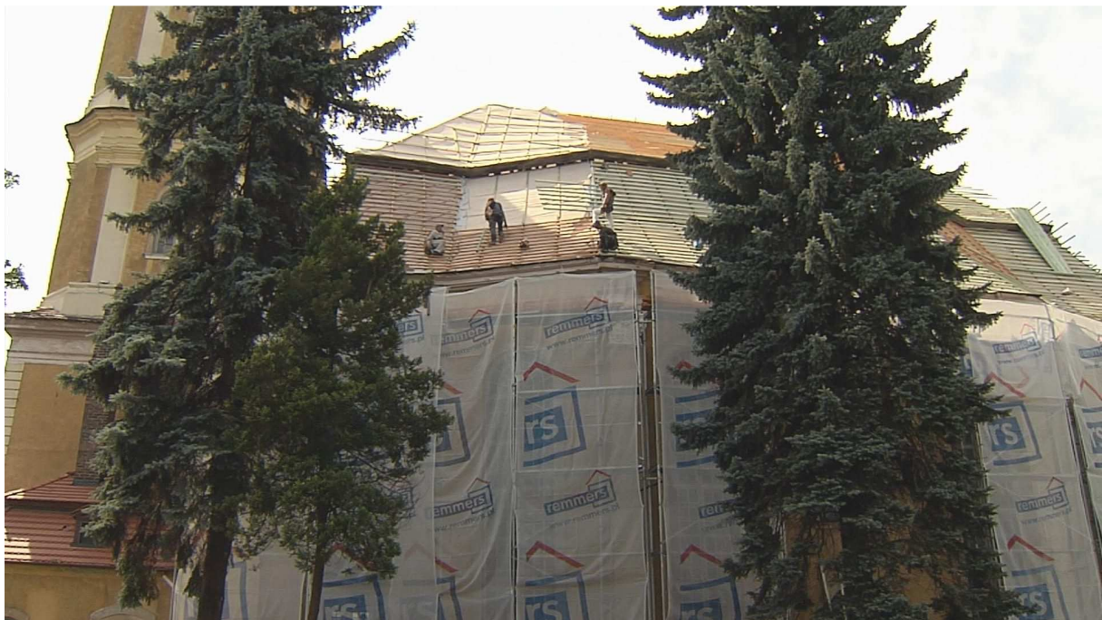
Aufbringung neuer Dachlattung auf dem Langhaus, August 2011 (Foto: Havel-Film Babelsberg, H.D. Rutsch)
