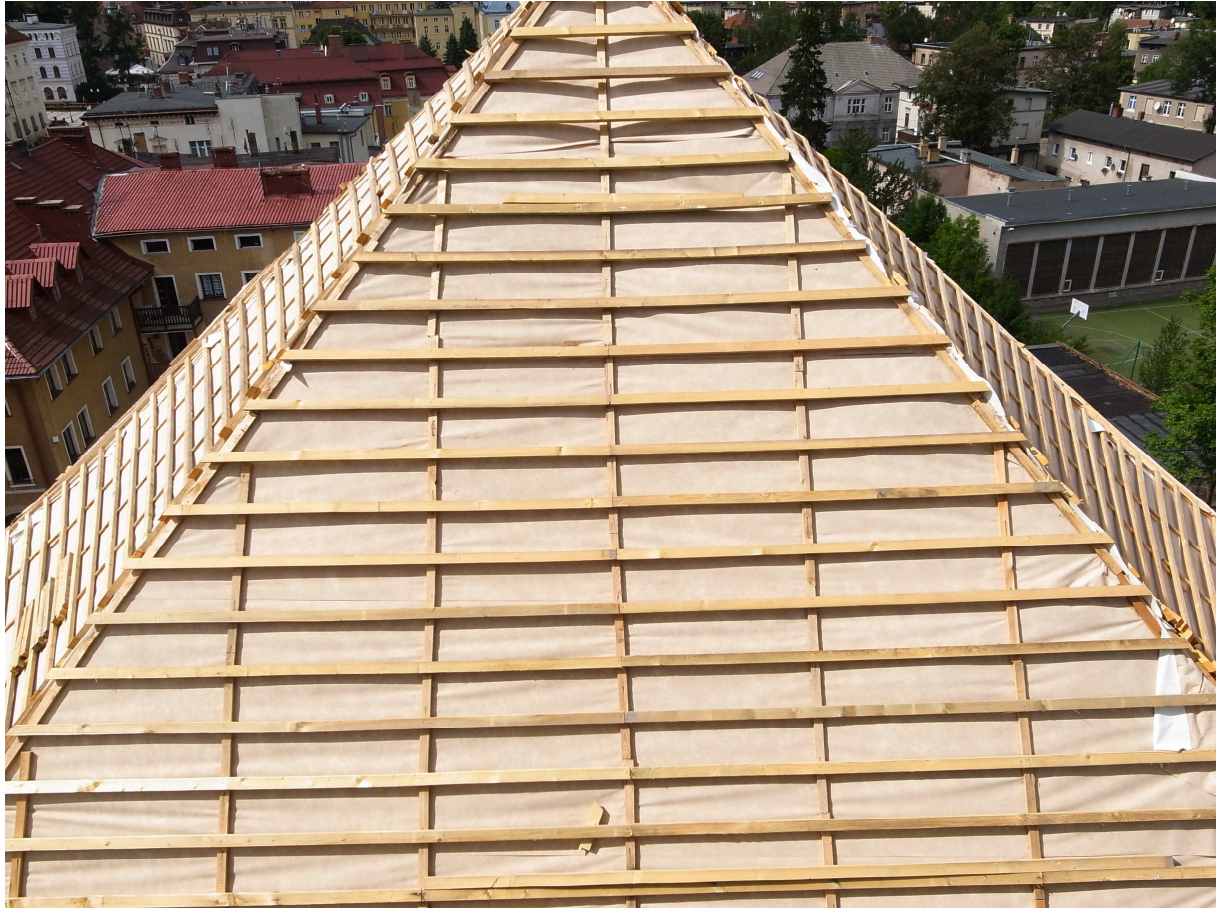
Blick über das abgedeckte Dach mit neuer Lattung gen Riesengebirge, August 2011
