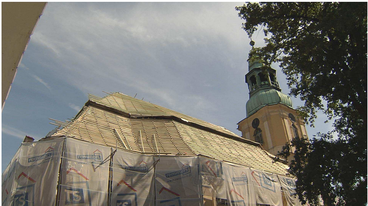
Mansarddach Langhaus mit neuer Dachlattung, August 2011 (Foto: Havel-Film Babelsberg, H.D. Rutsch)
