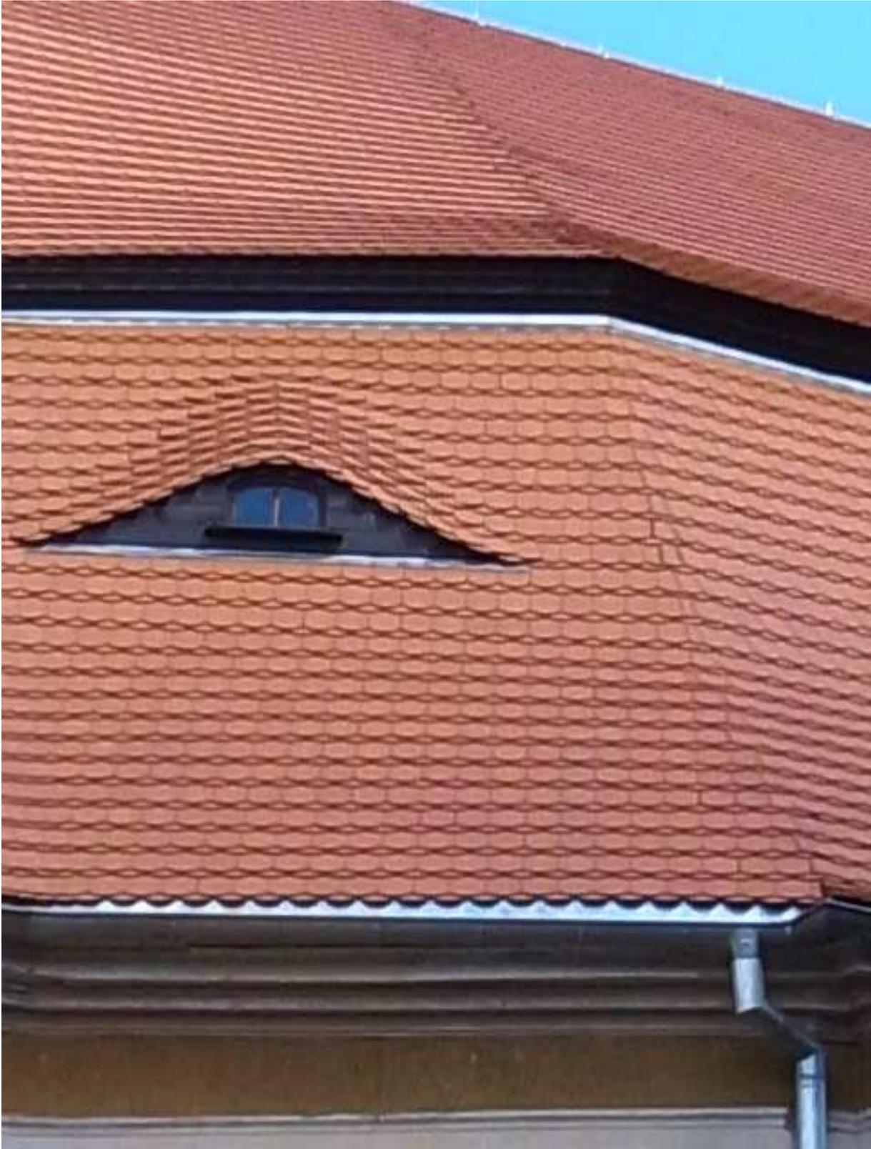
Schiffdachgrat nach Korrekturarbeit, August 2012
