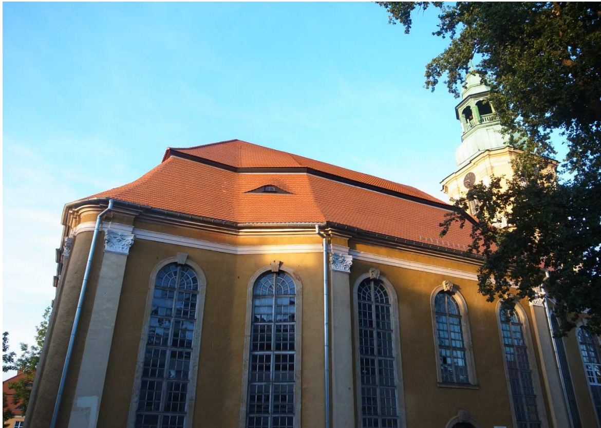
Dachsüdseite Schiff nach Dachdecker-Korrekturarbeiten, September 2012
