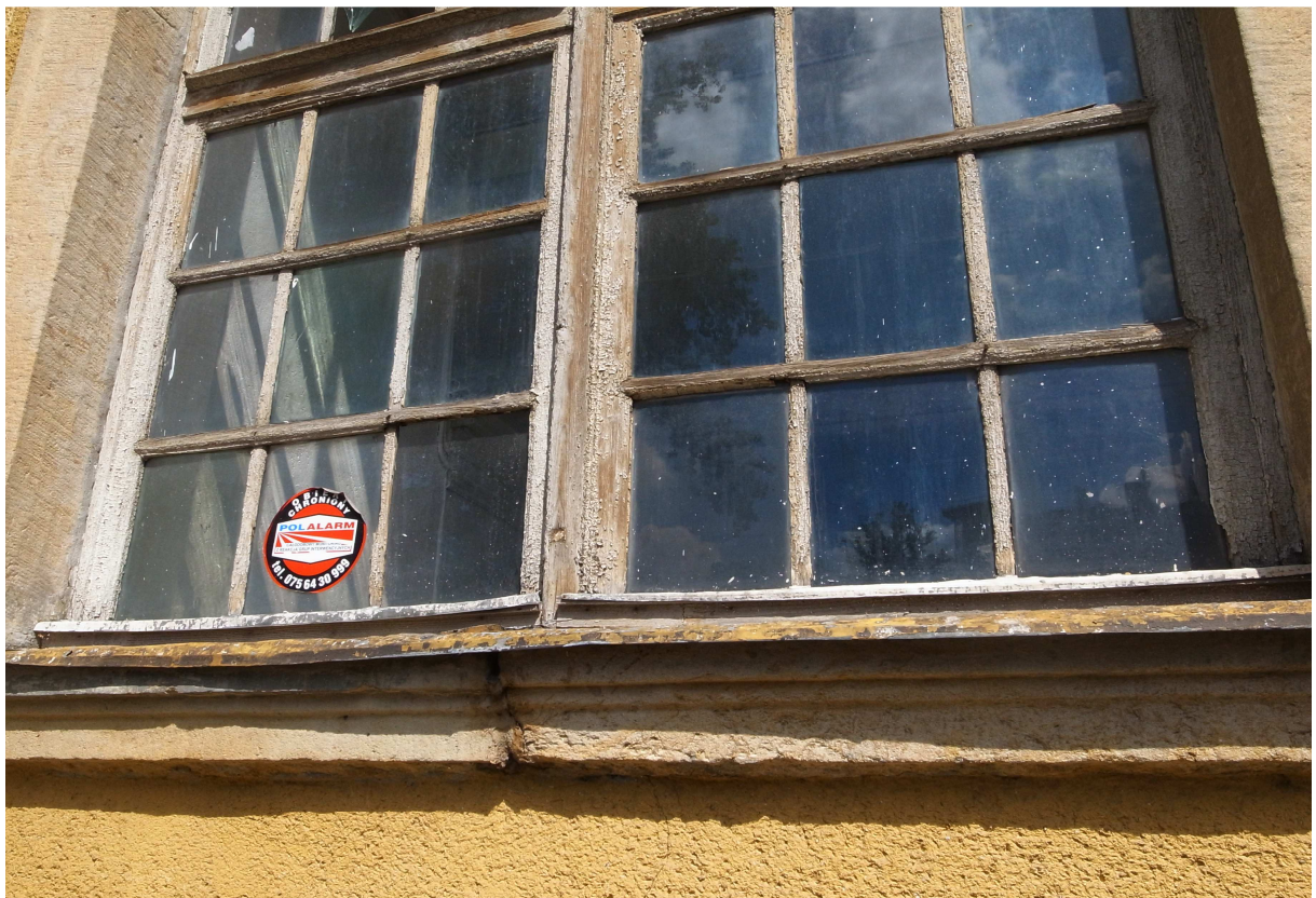
Fenster Schiffsüdseite, August 2012
