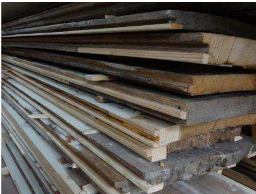
Tischlermäßig instand gesetzte Deckenbretter vor Restaurierung Malschicht und Wiedereinbau (Etappe 2), Herbst 2011 (Foto: Beata Makowska)
