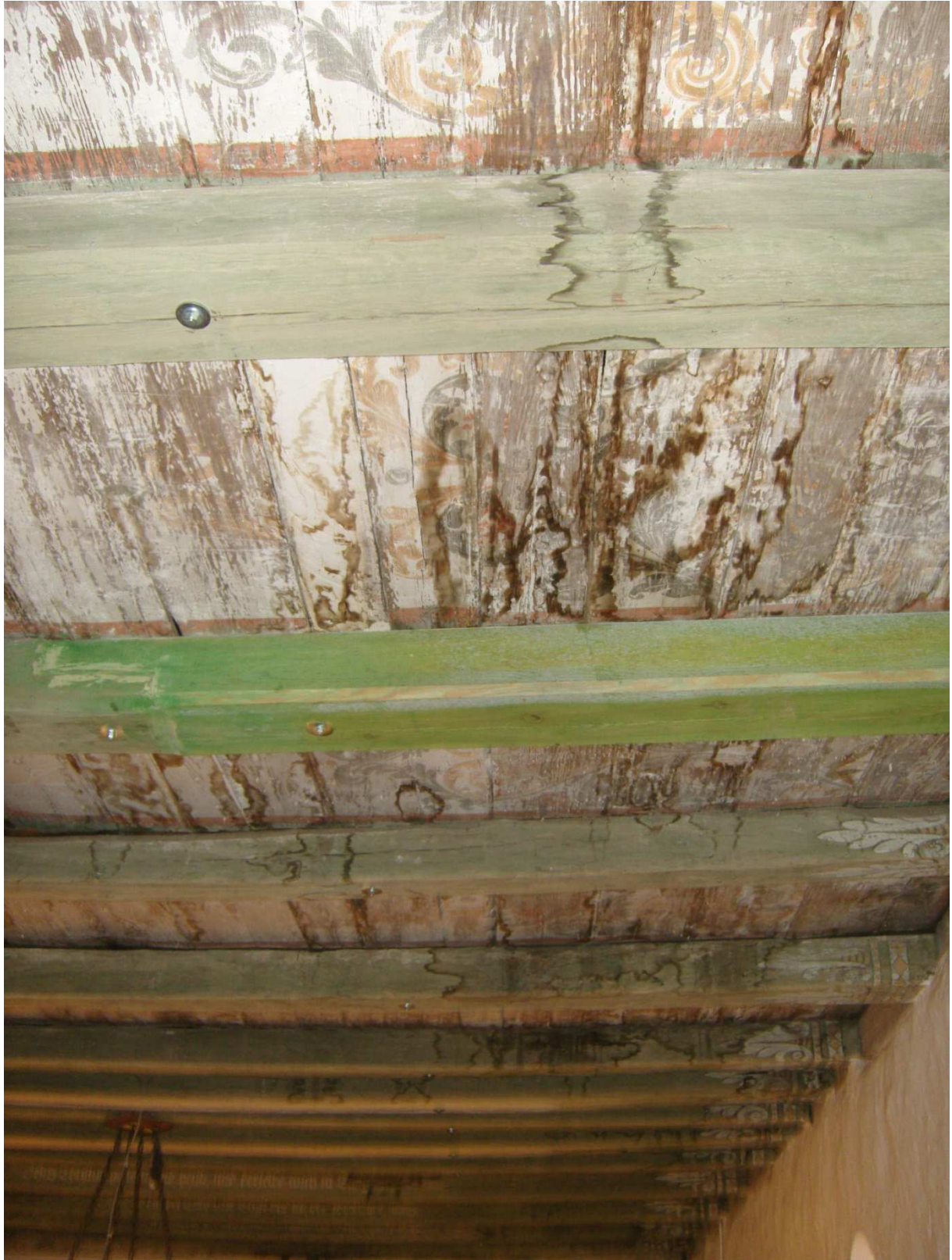
Deckenausschnitt mit repariertem Deckenbalken, Mai 2010
