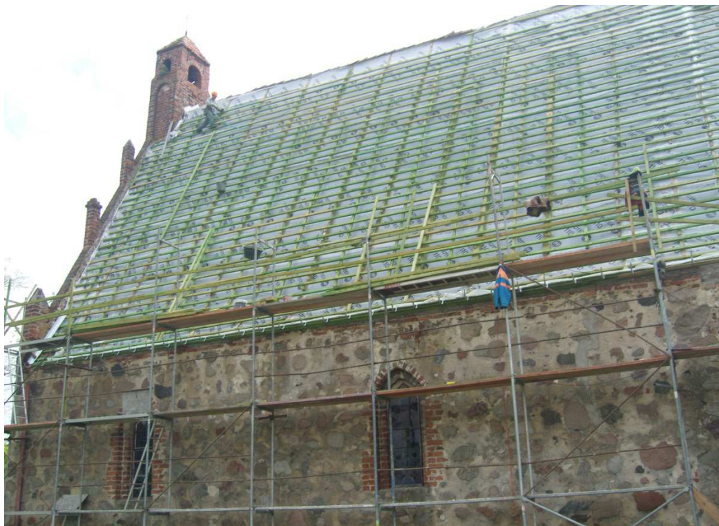
Dachinstandsetzung (Nordseite), abgeschlossen Juni 2010, Aufnahme Mai 2010
