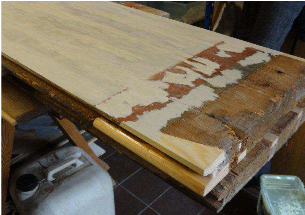
Tischlermäßig instand gesetzte Deckenbretter vor Restaurierung Malschicht und Wiedereinbau (Etappe 2), Herbst 2012 (Foto: Beata Makowska)
