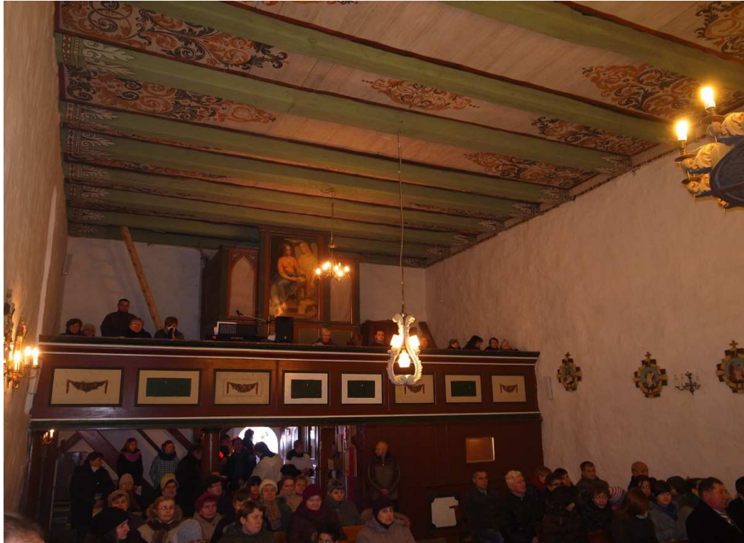
Dankgottesdienst am 17.12.12 zur Fertigstellung der Deckenrestaurierung, Blick nach Westen mit fertiggestellter Decke (Etappe 3)
