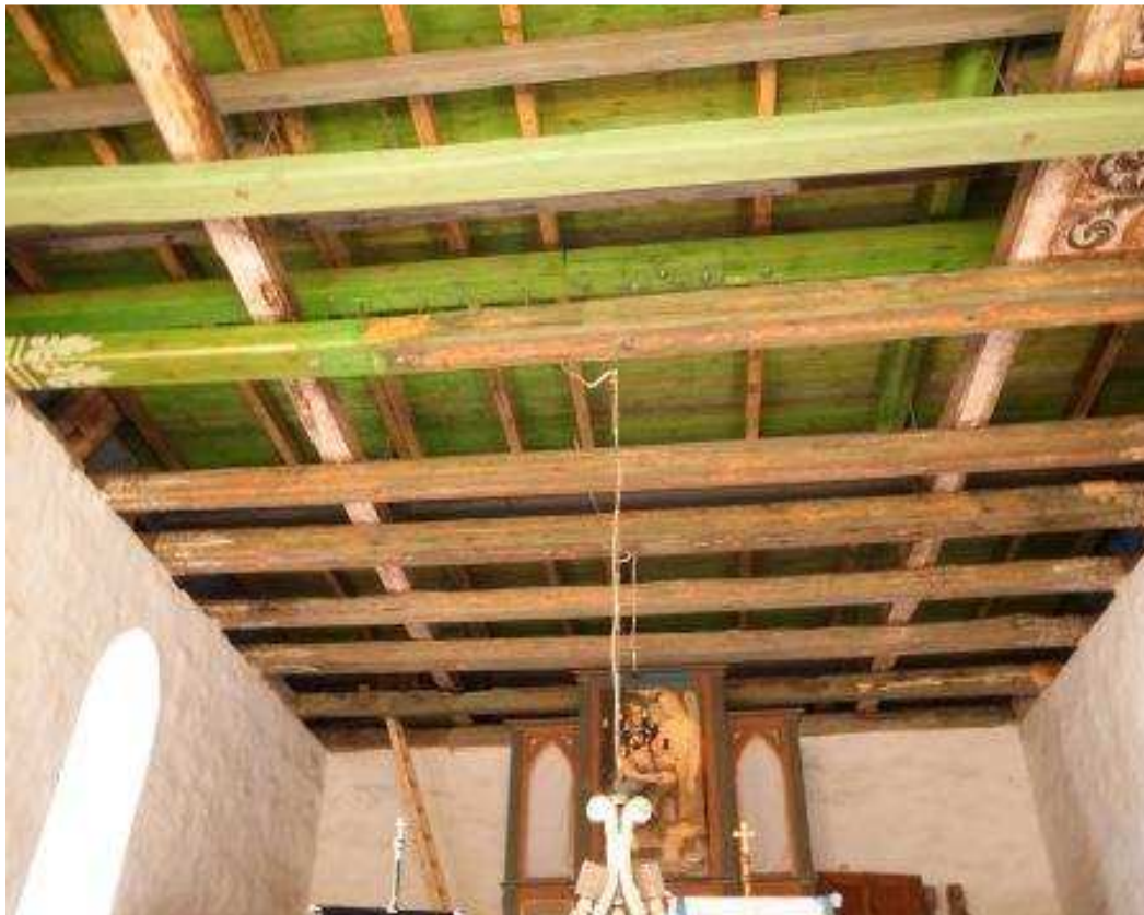
Wiederherzustellender westlicher Flächenabschnitt Schiffdecke (3. und letzte Etappe ), Zustand Januar 2012
