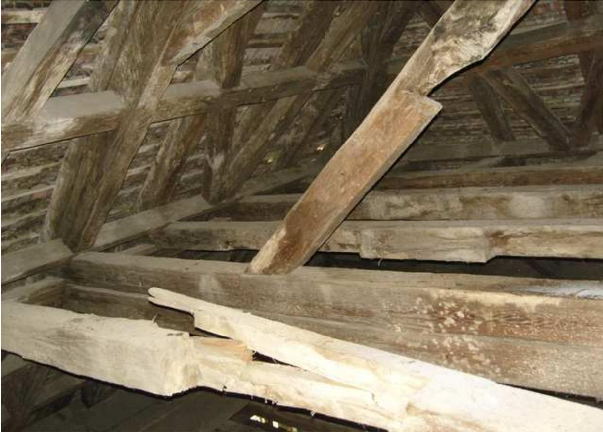
Statisch akut gefährdete Dach- und Decken-Holzkonstruktion im Kernbau des Schlosses, März 2010
