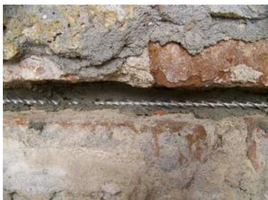
Mauerwerk mit in Fuge eingelegtem Edelstahl-Gewindestab vor Vermörtelung, 2013 (Foto: Architekturbüro festgrupa)
