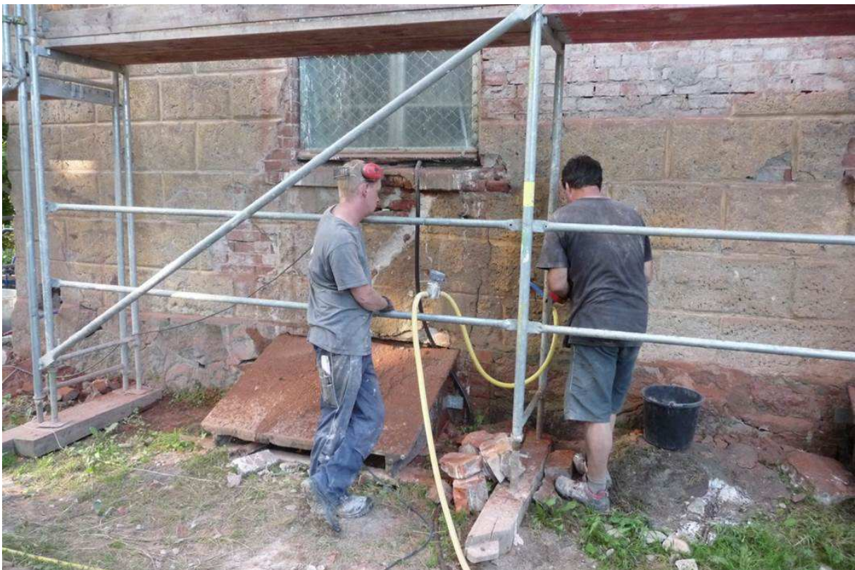
Sicherung Nordwestturm: Verpressung Riss-Nadeln, Sommer 2014 (Foto: W. Jäger)
