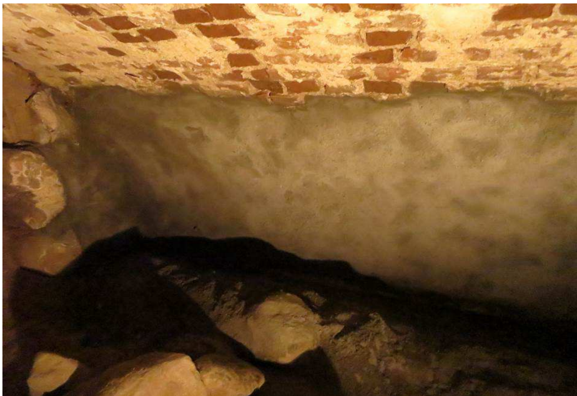
Gesichertes Mauerwerk Keller 1.01 und 1.02 des Kernbaues, Winter 2014 (Foto: W. Jäger)
