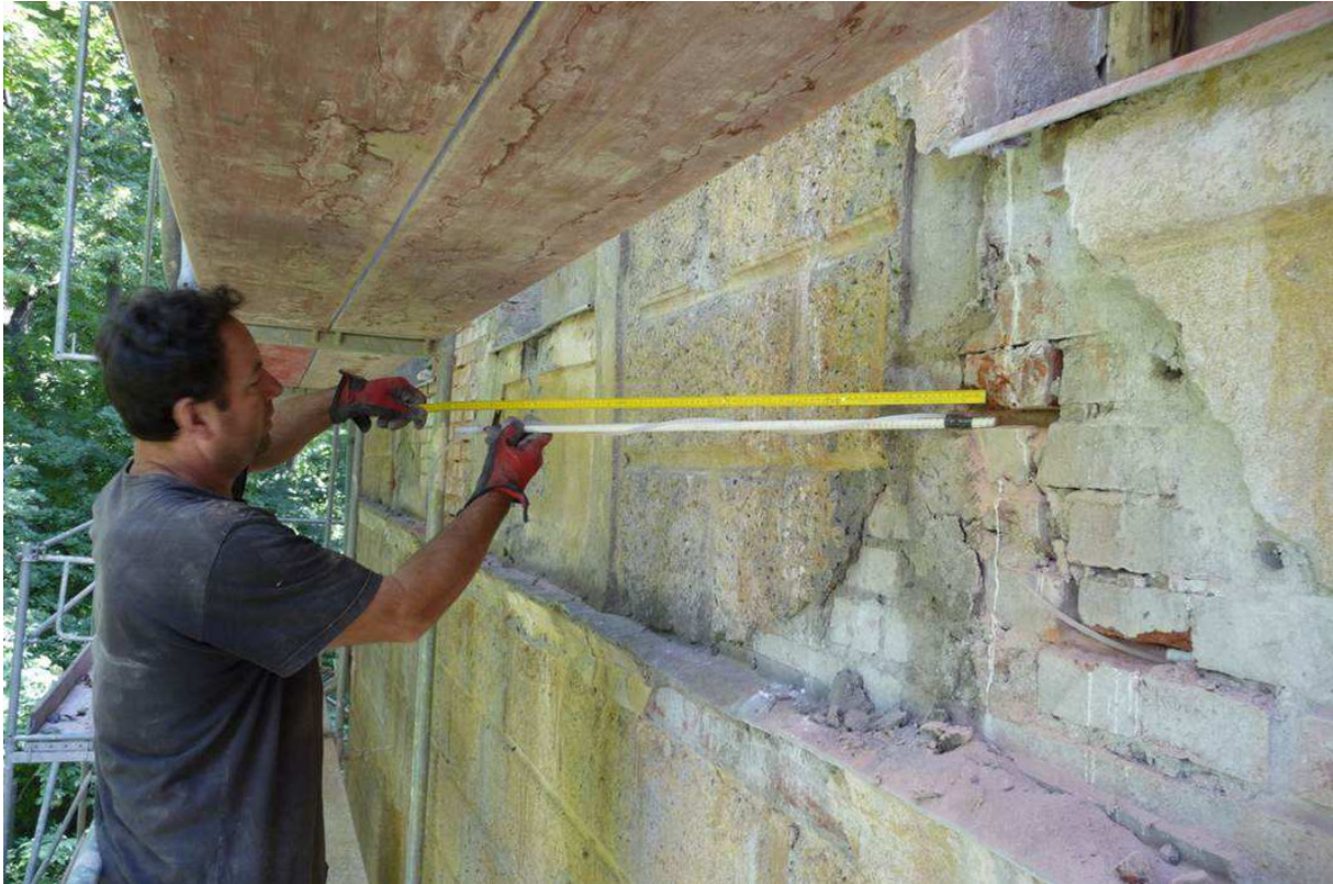
Sicherung Nordwestturm: Bohrung und Einsetzen Riss-Nadeln, Sommer 2014 (Foto: W. Jäger)
