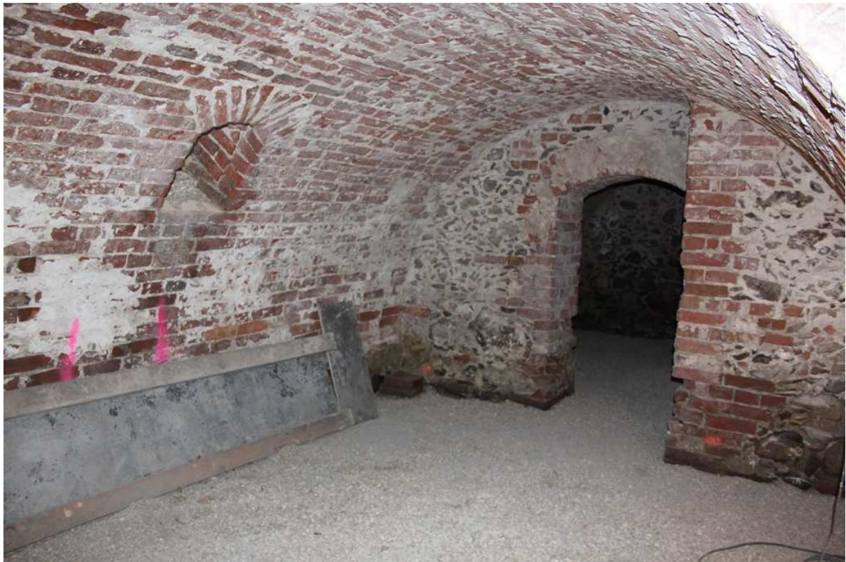
Kellergewölbe nach Fundament- und Sockelzonen-Instandsetzung, Sommer 2015
