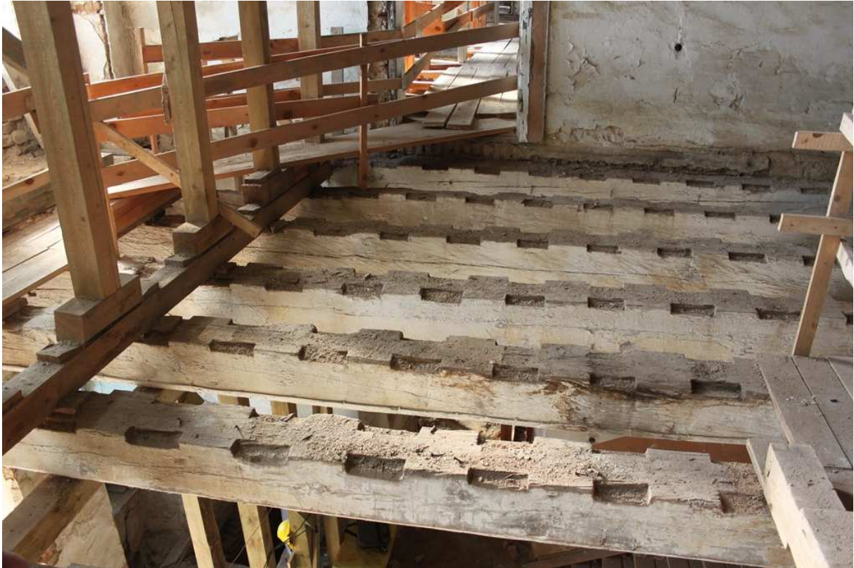
Deckenbalkenebene zwischen EG und OG im Kernbau von Schloss Steinort, Sommer 2015
