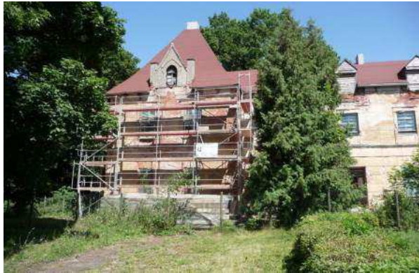
6. Sicherungsmaßnahme Schloss Steinort (2014) „Statische Sicherung Nordwestturm“, Sommer 2014 (Foto: W. Jäger)
