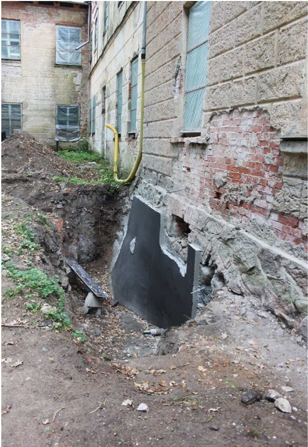
Luftdurchlässige Vertikalabdichtung Kelleraußenwand an der Rückseite (Parkseite) von Schloss Steinort, Sommer 2015
