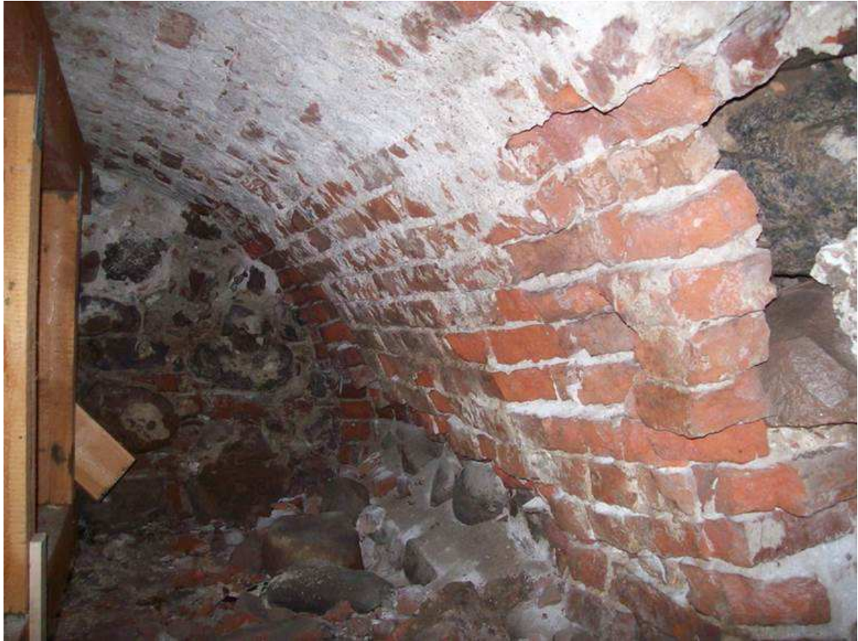
Sicherung Mauerwerk Keller 1.01 und 1.02 des Kernbaues (Mittelbau), Winter 2014 (Foto: W. Jäger)
