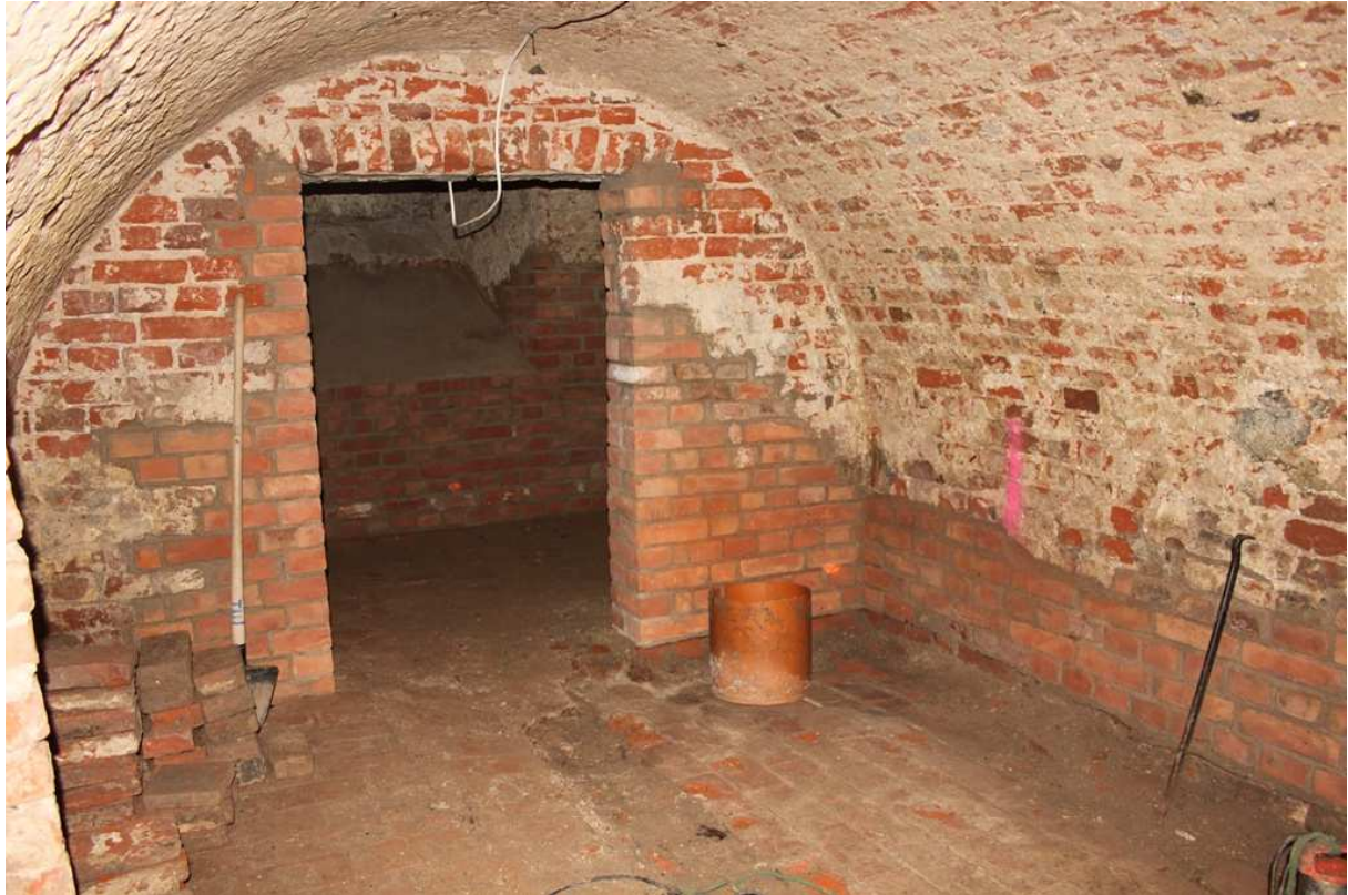
Kellergewölbe nach Fundament-, Wandsockel- und Eingangswandinstandsetzung, Sommer 2015
