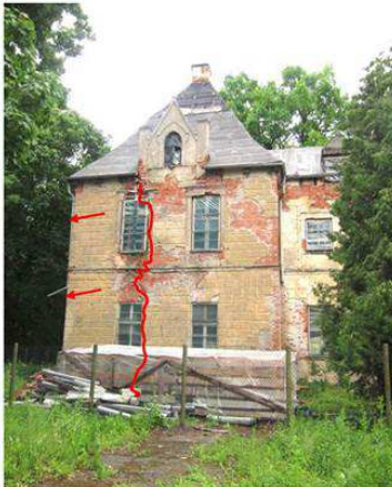
Statische Sicherung am Nordwestturm
