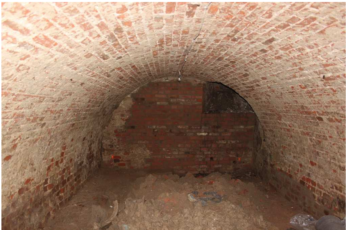
7. Sicherungsetappe (2015): Kellergewölbe nach Fundamentbearbeitung mit noch nicht wieder installiertem Ziegelfußboden, Juli 2015
