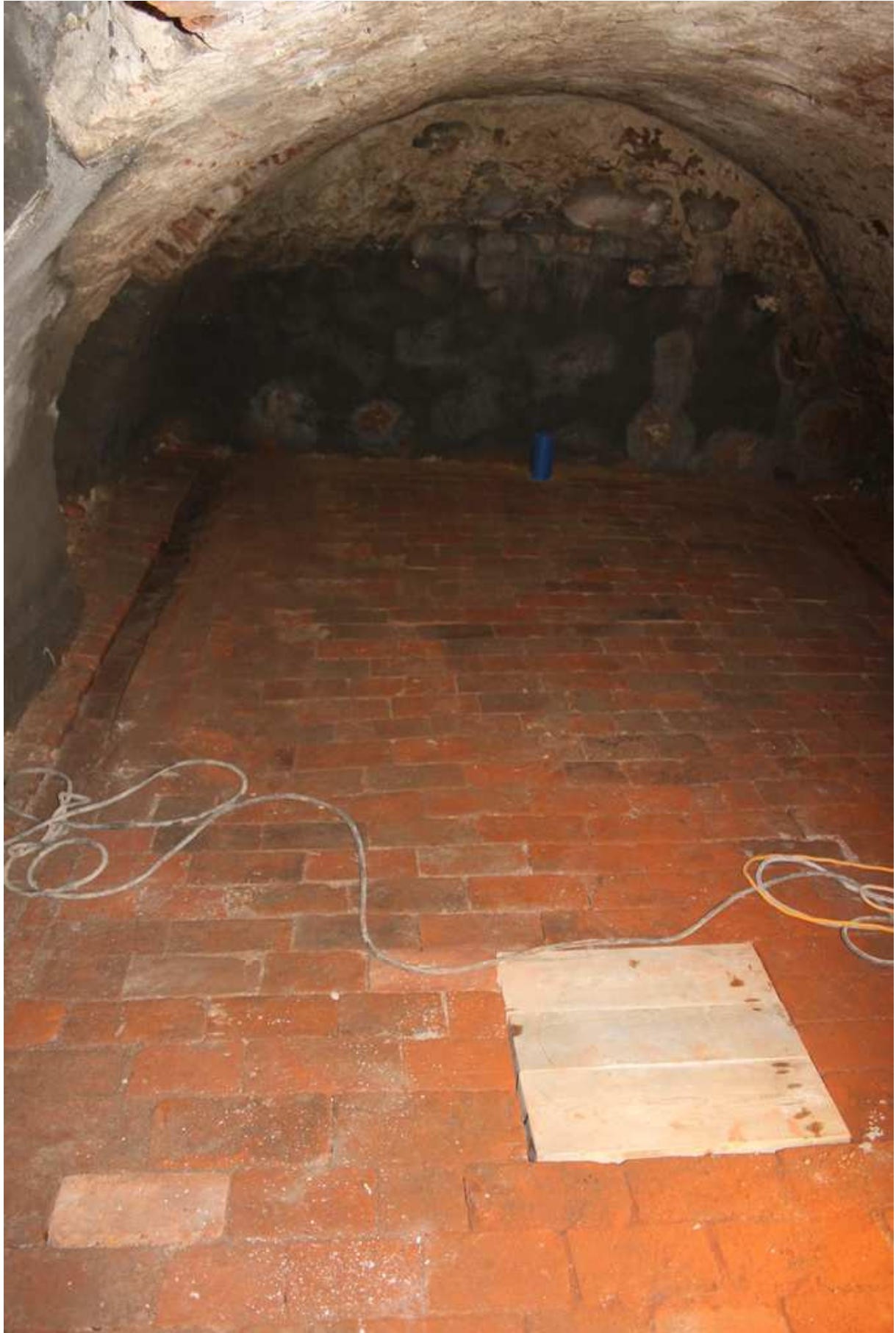
Kellergewölbenach Fundamentbearbeitung mit wieder eingebautem Ziegelfußboden, August 2015
