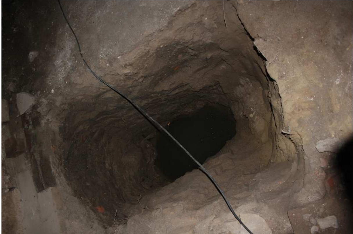
Unter Fundamentniveau ergrabener Drainagekanal außen am Nordwestturm (Westseite), August 2015
