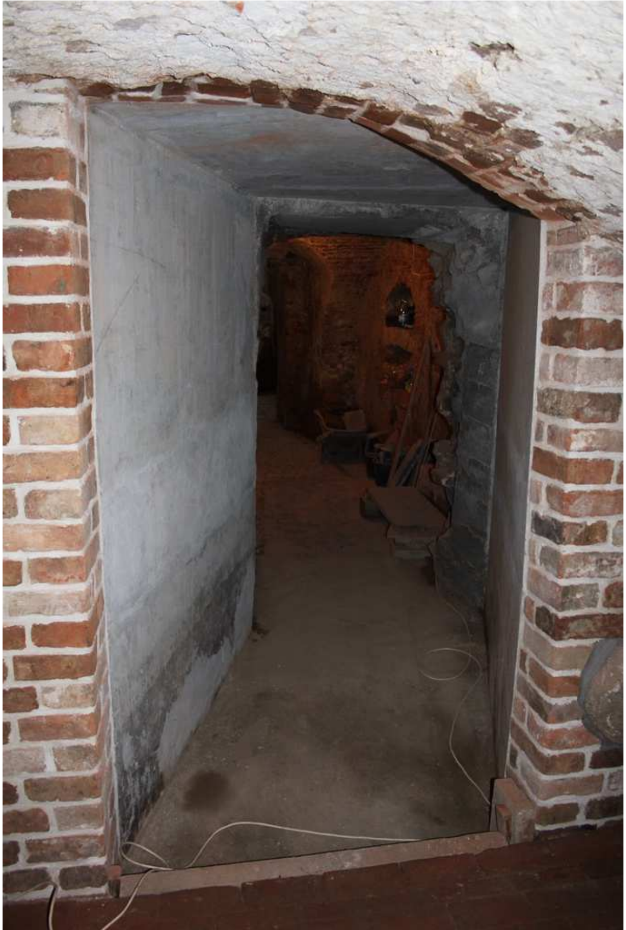
Instandgesetzter Kellerdurchgang am Übergang Kernbau/Westflügel, Sommer 2015
