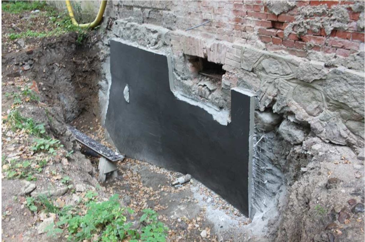
Luftdurchlässige Vertikalabdichtung Kelleraußenwand an der Rückseite (Parkseite) von Schloss Steinort, Sommer 2015
