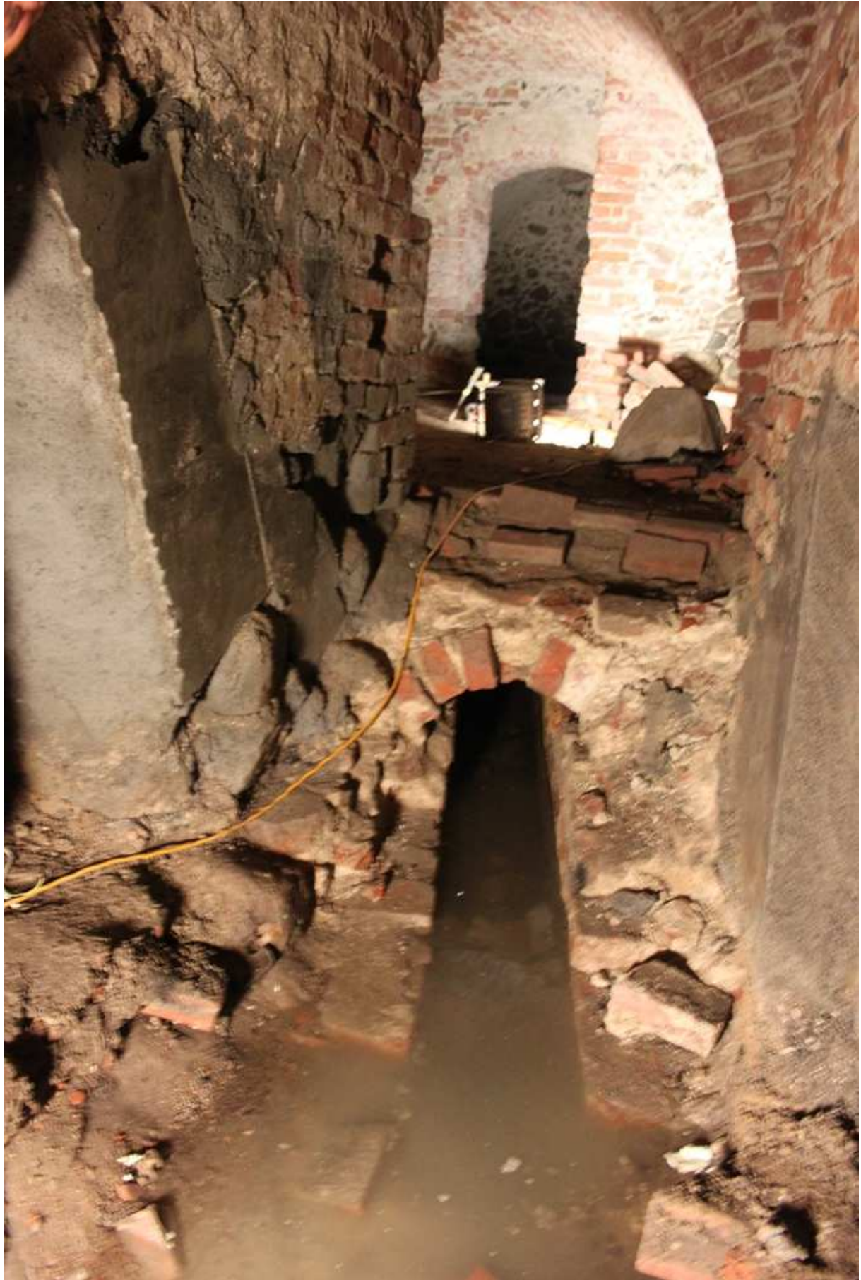
Freigelegter historischer Drainagekanal im Westflügel, Sommer 2015
