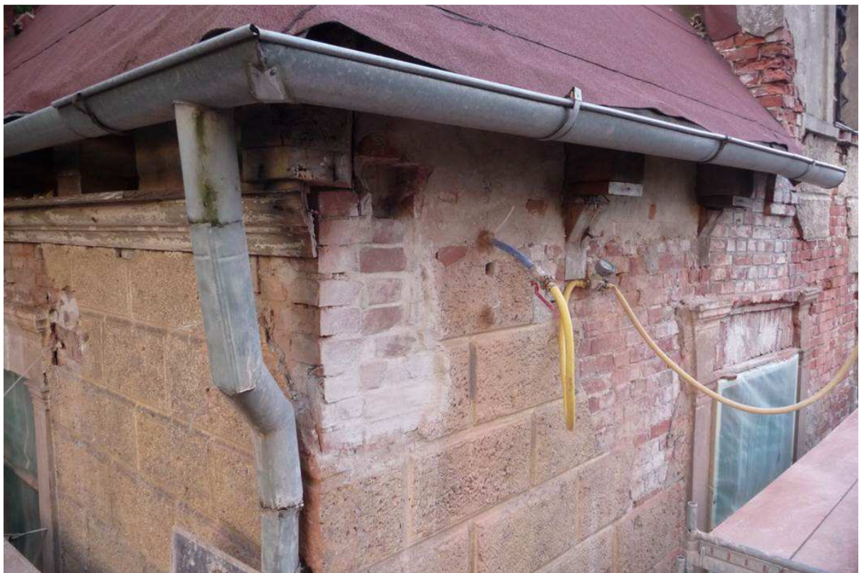
Sicherung Nordwestturm: vermauerter Ankerkopf, Sommer 2014 (Foto: W. Jäger)
