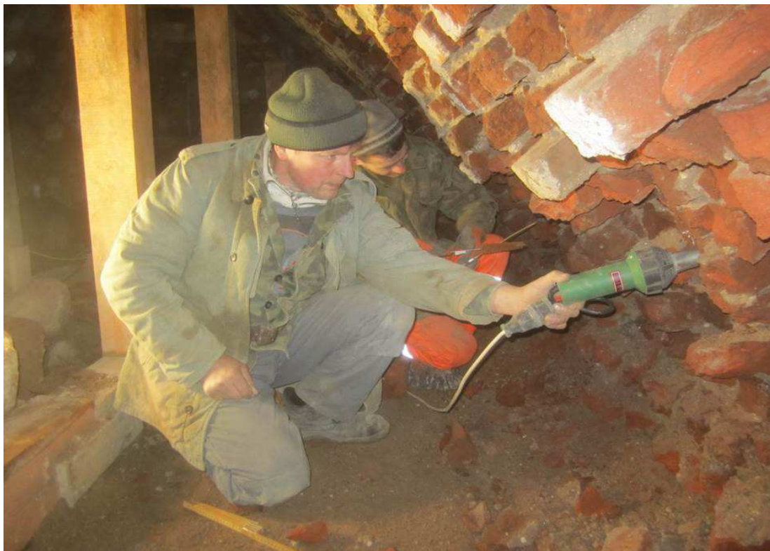
Sicherung Mauerwerk Keller 1.01 und 1.02 des Kernbaues (Mittelbau), Winter 2014 (Foto: W. Jäger)
