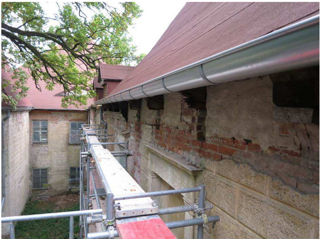
Sicherung Nordwestturm: Dachrinne nach Reparatur. Sommer 2014 (Foto: W. Jäger)
