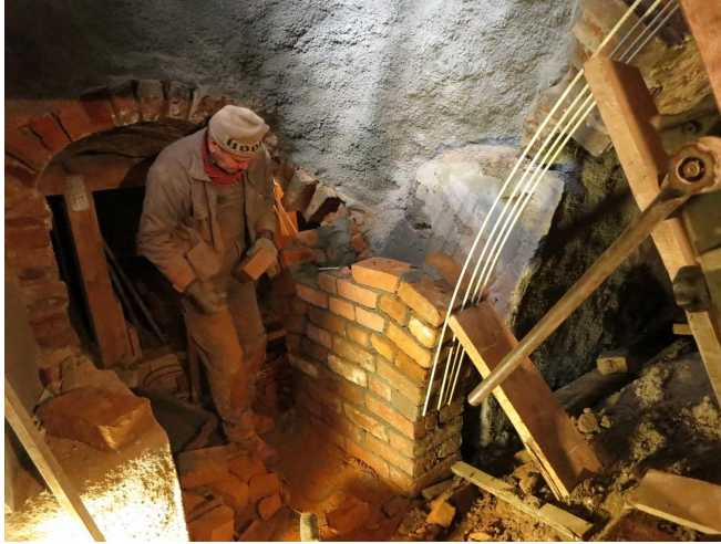
Ergänzung von Mauerwerk im Keller
