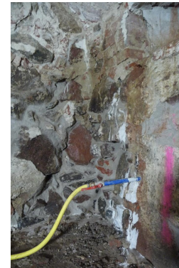
Verpressen von Mauerwerk im Keller
