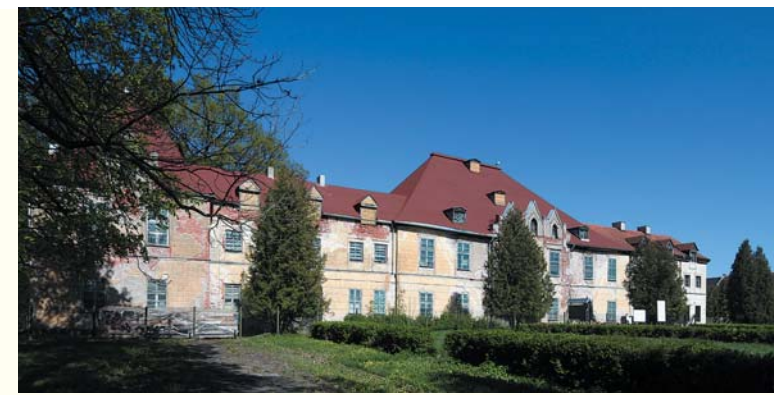
Steinort/Sztynort, Hauptfassade des Schlosses (Förderprojekt ab 2009)
