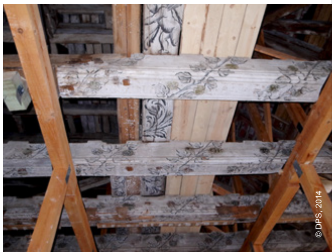
Viele der originalen barocken Deckenbalken im Schloss können erhalten werden
