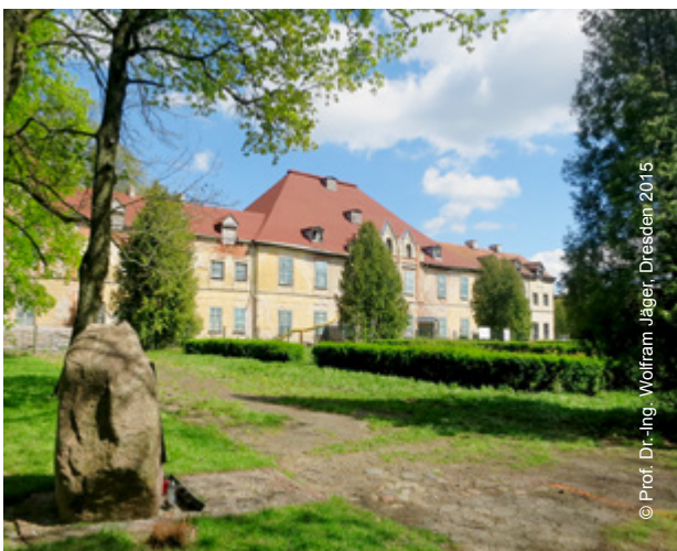
Vorderansicht des sanierungsbedürftigen Schlosses
