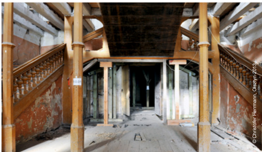
Ansicht der repräsentativen Haupttreppe im Kernbau
