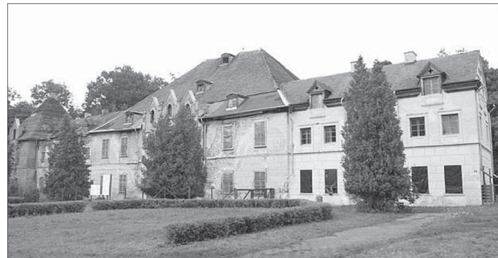
Pałac w Sztynorcie przed rozpoczęciem prac remontowych (Autor: Archiwum PNFOZK)
