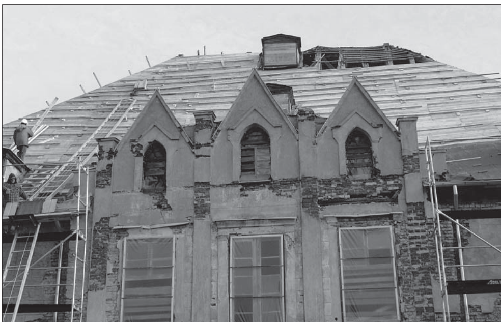
Sztynort/Steinort, Schloss. Aufbringung einer neuen Dachnoteindeckung im Oktober / November 2011 / Montaż nowego pokrycia dachu, jesień 2011 | T. Cichonski
