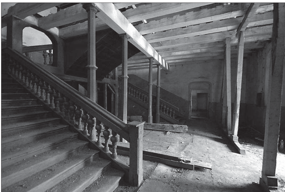
Treppenhaus im Schloss Steinort / Klatka schodowa w pałacu w Sztynorcie | Deutsch-Polnische Stiftung Kulturpflege und Denkmalschutz
