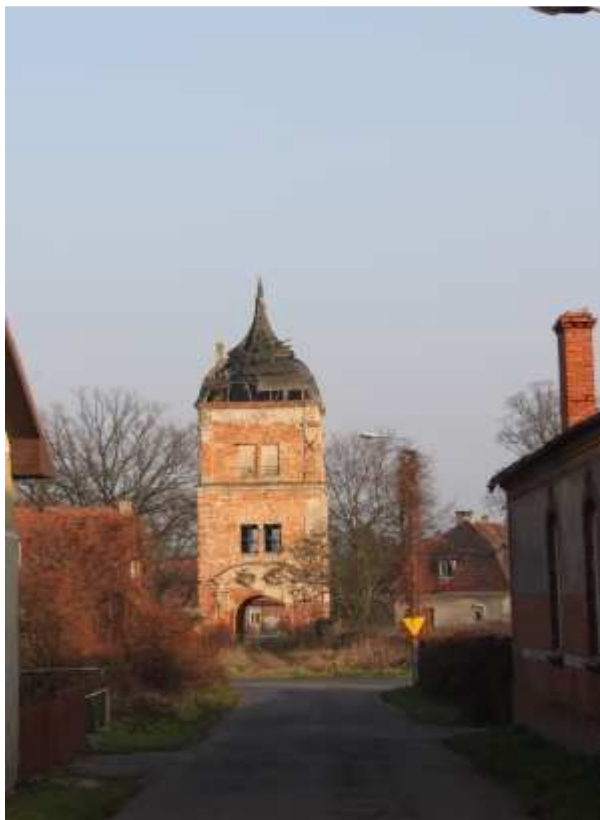
Torturm des ehem. Johanniter-Ordensamts in Schenkendorf / Sękowice
