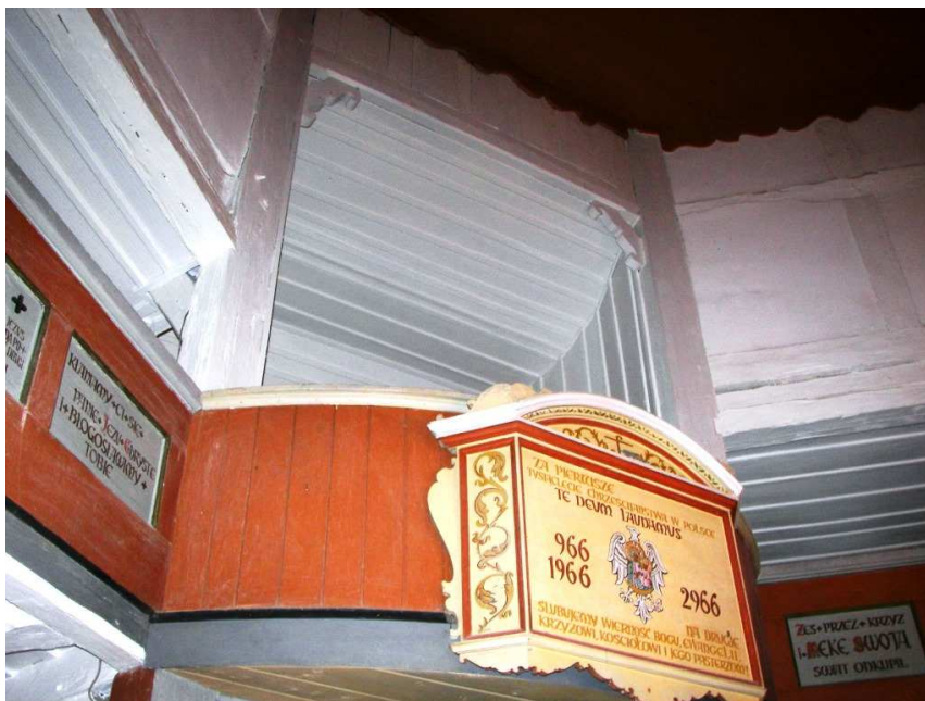
Außenansicht der im Teil-BA 2015 instand gesetzten Emporen-Westseite, Dezember 2015 (Foto: Kath. Kirchengemeinde)
