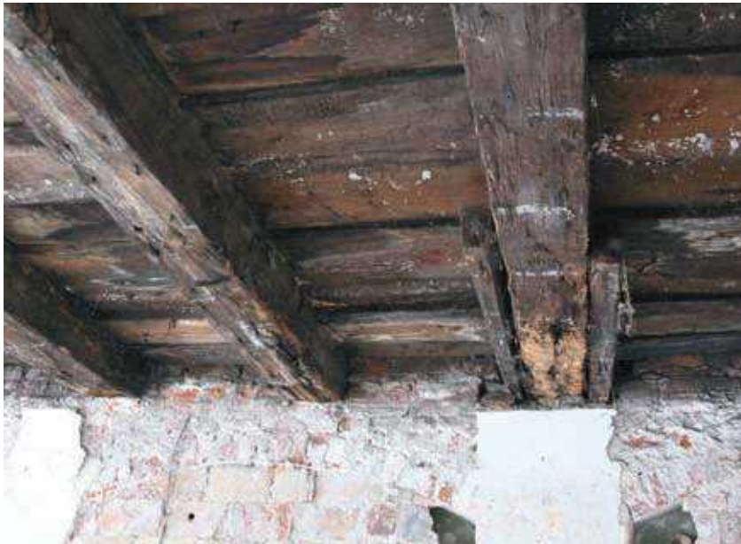
Oppenheim Haus - Holzbalkendecke vor der Restaurierung, 2016. Fot. DPS
