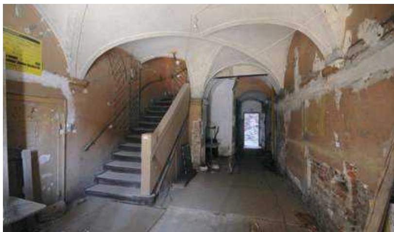
Oppenheim Haus - Eingangshalle vor der Restaurierung 2016, Fot. DPS
