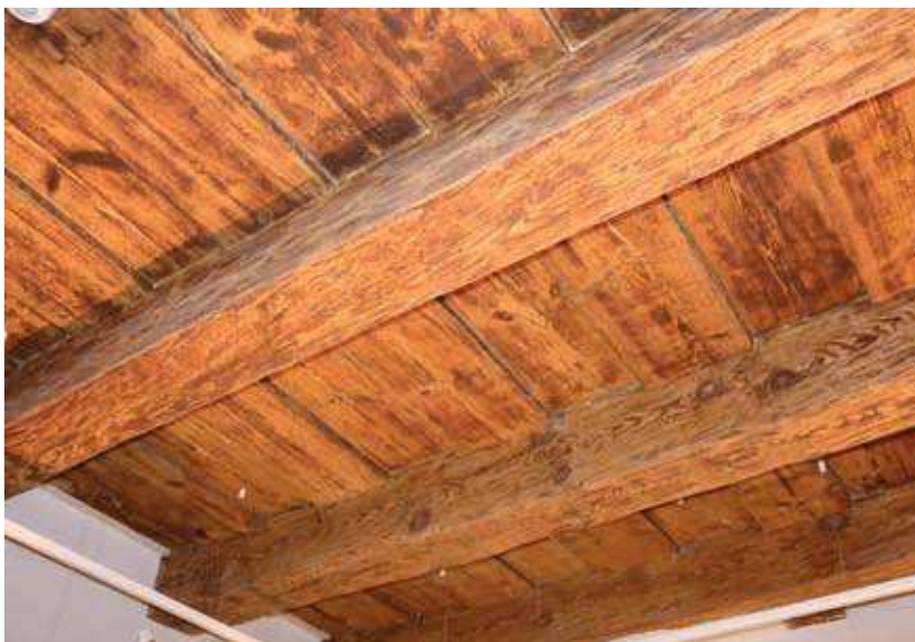
Oppenheim Haus - Holzbalkendecke nach der Restaurierung, 2018. Fot. DPS
