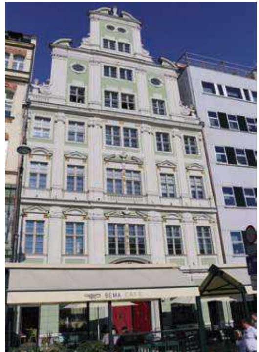
Oppenheim Haus - Fassade nach der Restaurierung, 2018. Fot. DPS
