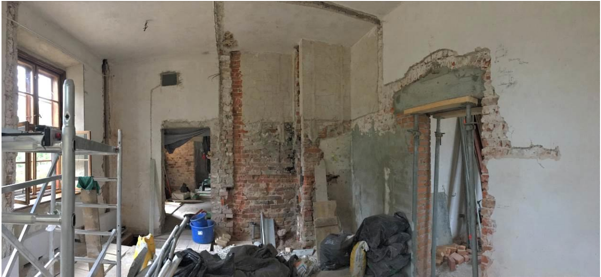
Bild 4 Das Informationszentrum vor Beginn der Bauarbeiten am 28.10.2019 Bild-12.jpg
