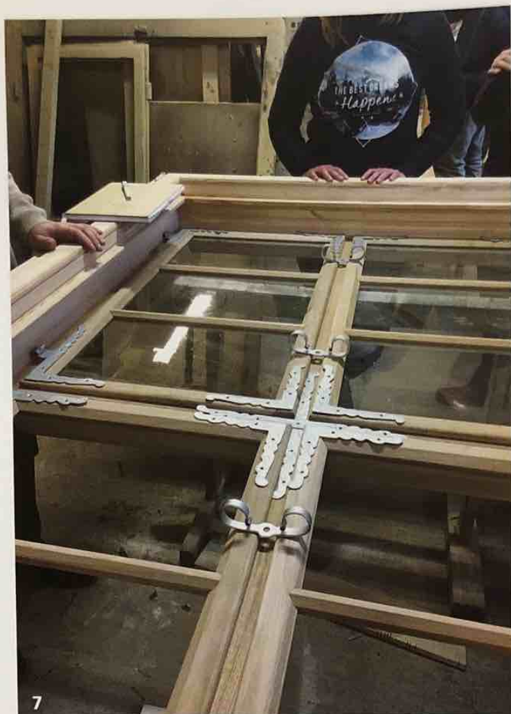
7 | Renowacja drewnianych obramień okiennych
