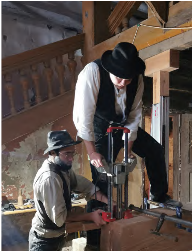
Reparatur von Balken, August 2021
