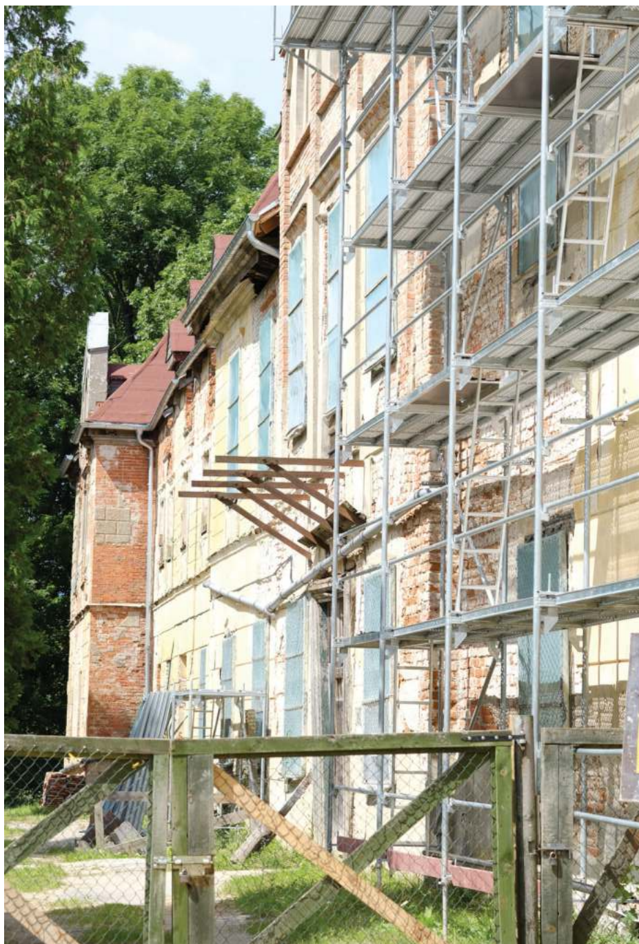
Główna fasada pałacu w Sztywnicy, sierpień 2020 r.
