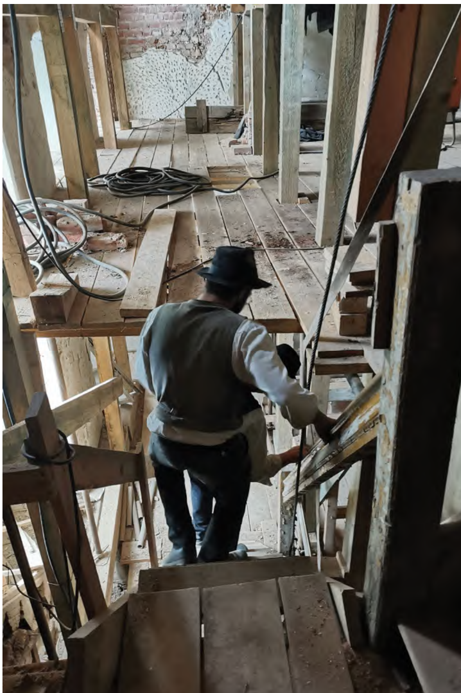
Bauarbeiten im Schlossinnern, Sommer 2021
