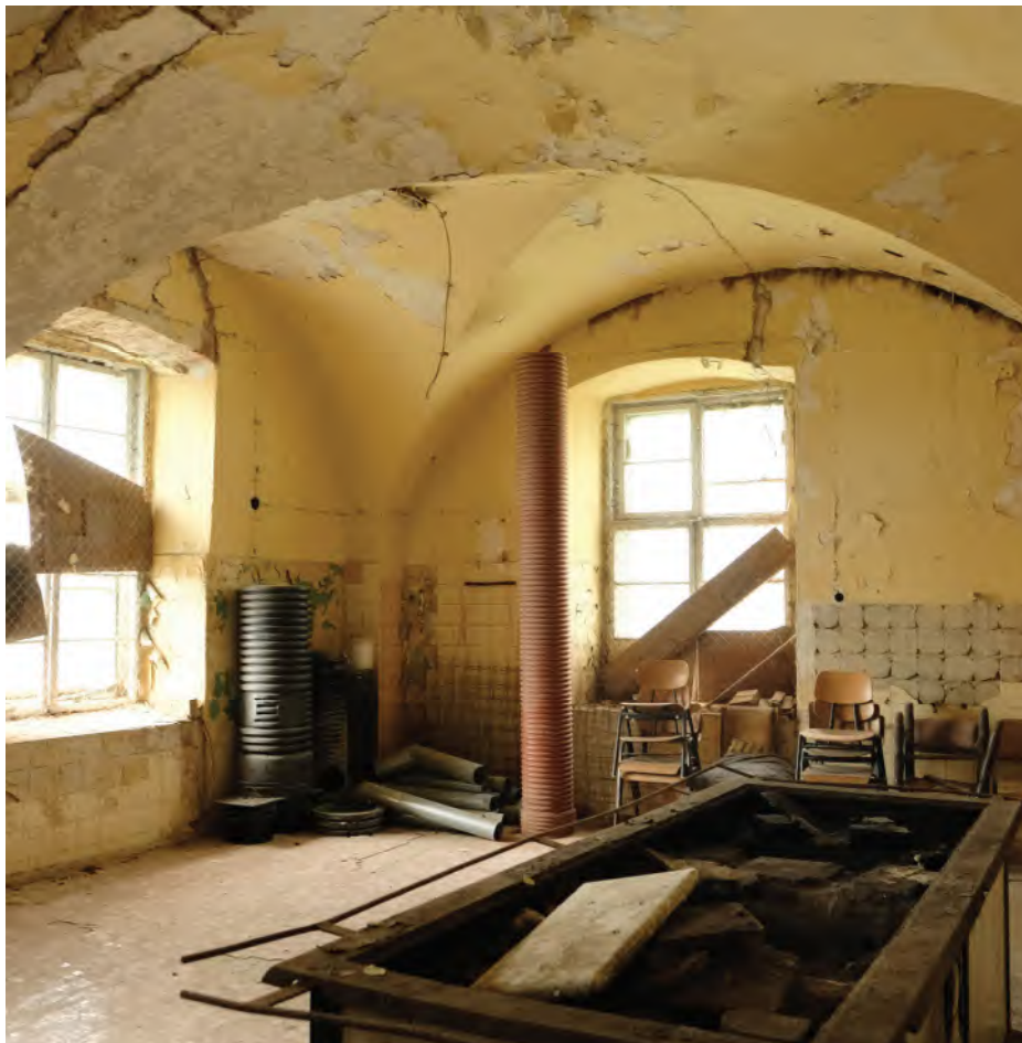
Ehemalige Schlossküche im Westturm, 2020
